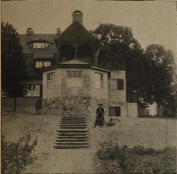
Abb. 30. Ansicht von Südwesten her.
