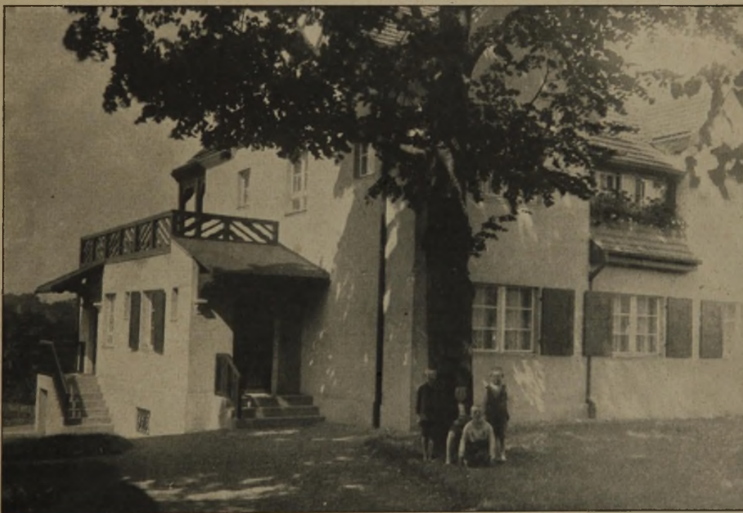
Abb. 32. Ansicht von Osten mit Haupt- und Nebeneingang. Landhaus in Altruppin.
