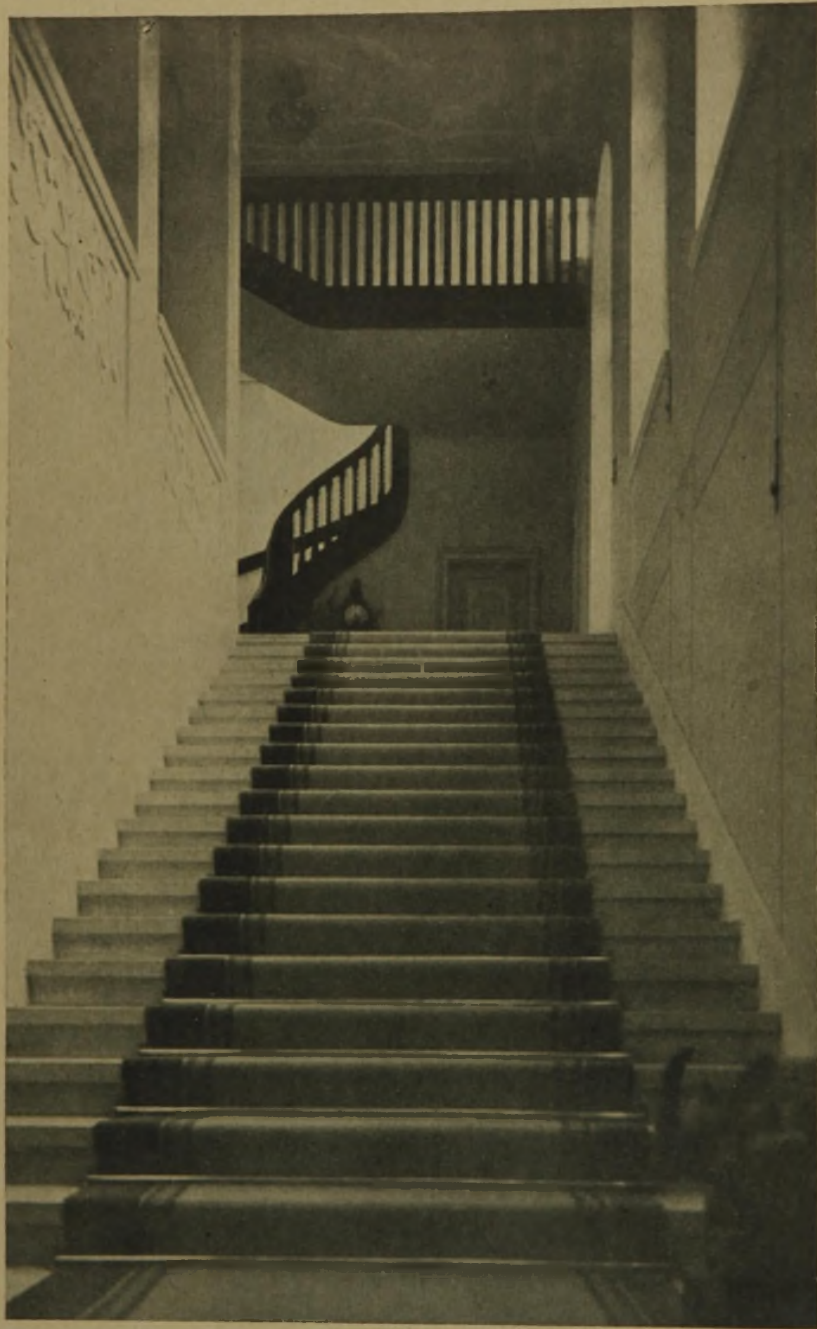
Abb. 12. Haupttreppenlauf vom Vestibül im Untergeschoß zum Hauptgeschoß.
