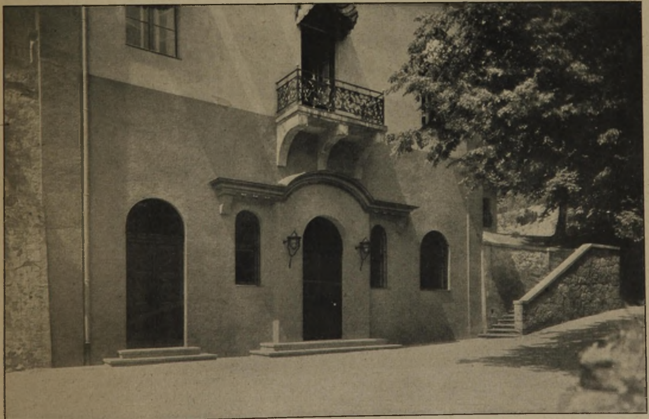
Abb. 1. Blick auf eine Seitenfront mit Haupteingang.
