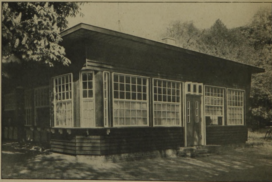
Abb. 2. Kopfbau des Strandpavillons. Umbau eines Strandpavillons am Wannsee.
