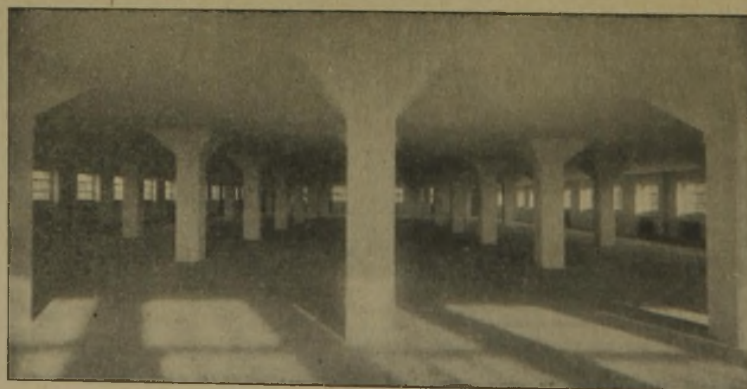
Abb. 16. Blick in ein Obergeschoß des Magazingebäudes.
