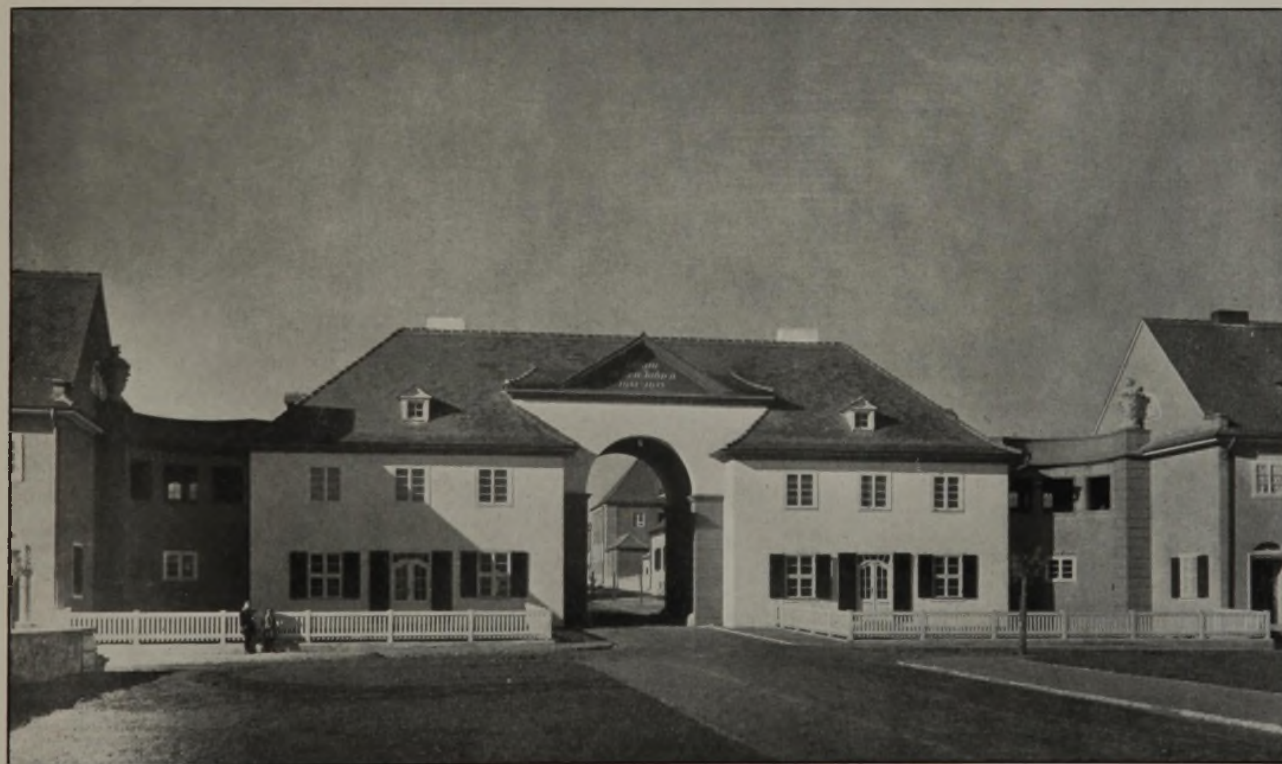
DIE OSTMARKBAUTEN IN FRANKFURT A. D. ODER GARTENSIEDLUNG PAULINENHOF OBEN: ÖSTLICHE EINGANGSGRUPPE VOM KIESSLING-PLATZ UNTEN: TORHAUS AM WESTEINGANG ZUR SIEDLUNG ARCHITEKT: REGIERUNGSBAURAT MARTIN KIESSLING IN KÖLN DEUTSCHE BAUZEITUNG. LIX. JAHRGANG 1925. NR. 93
