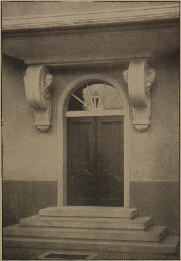
Abb. 23. Hauseingang im Wohnhof. Häuserblock am Wieckeplatz. (Phot. Bayer & Schmölz, Köln-Nippes.)
