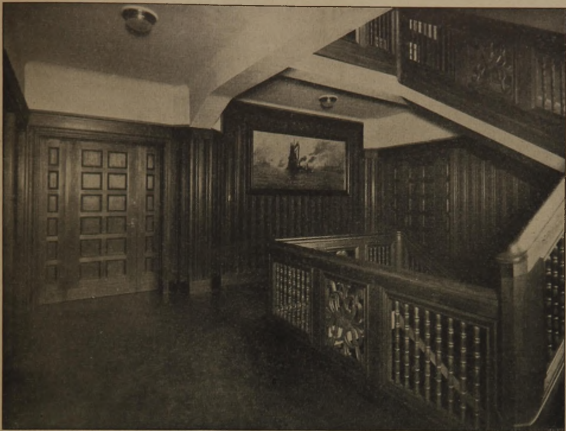
Abb. 5. Treppenhaus im Obergeschoß.
