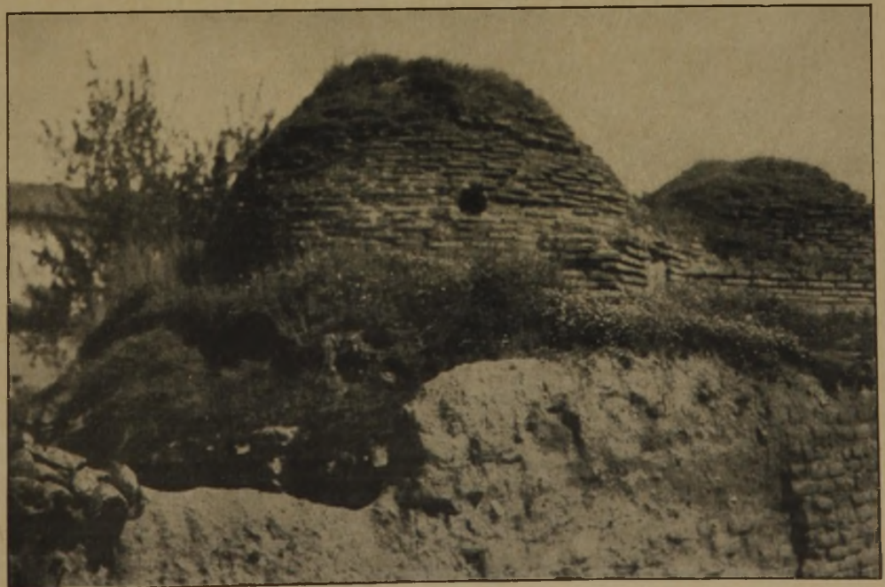
Abb. 26 (rechts). Alter Hamam in Angora. Kuppel aus Flachziegeln. Vorne Öffnung für Glasauge (Blei- oder Ziegel-Dachdeckung entfernt).
