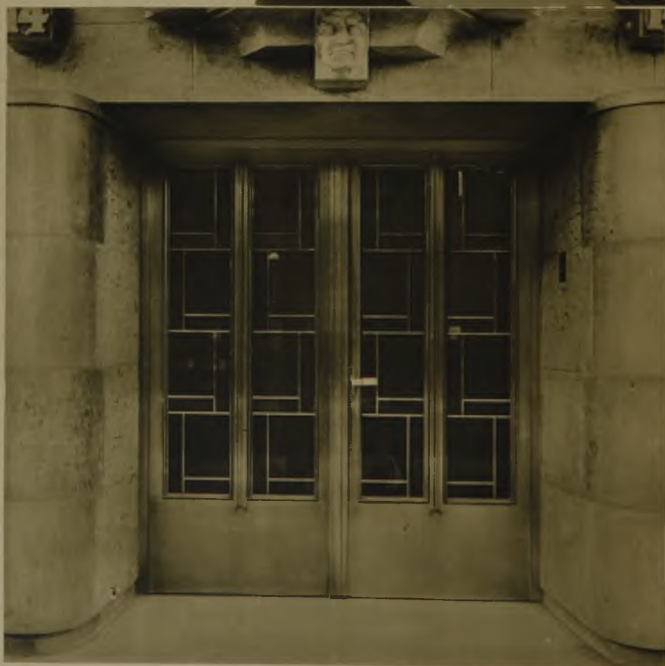
Haupteingang vom Ver- lagsgebäude deutscher Konsum-Vereine Hamburg ARCH. HANKE, HAMBURG Mattgeschliffenes Durana- Metall in Goldton der Dürener Metallwerke Ausführung: A. O. Metelmann, Hamburg
