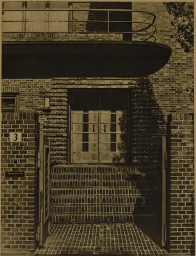
Blick von der Gartenpforte auf den Haupteingang
