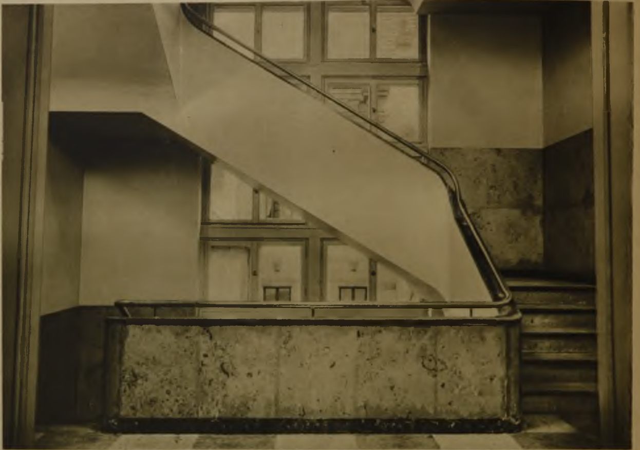
DAS VERWALTUNGSGEBÄUDE DER ELEKTRIZITÄTS-GES. FULDA A.-G. IN FULDA Treppenhaus ARCHITEKT AD. H. ASSMANN, BDA, FRANKFURT A. M.
