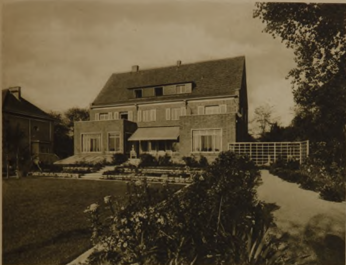
Ansicht von Süden. Hellbunte Buca-Klinker, braune Biberschwänze, Sockel und Gartenmauern Kleinschilderfelder Muschelkalkstein. Überleitung vom Haus zum Garten durch die Mittelstufe, deren Zwischenpodeste mit dem ringsum führenden Grenzweg und mit den durch Trockenmauern gestützten Pflanzterrassen verbunden sind.
