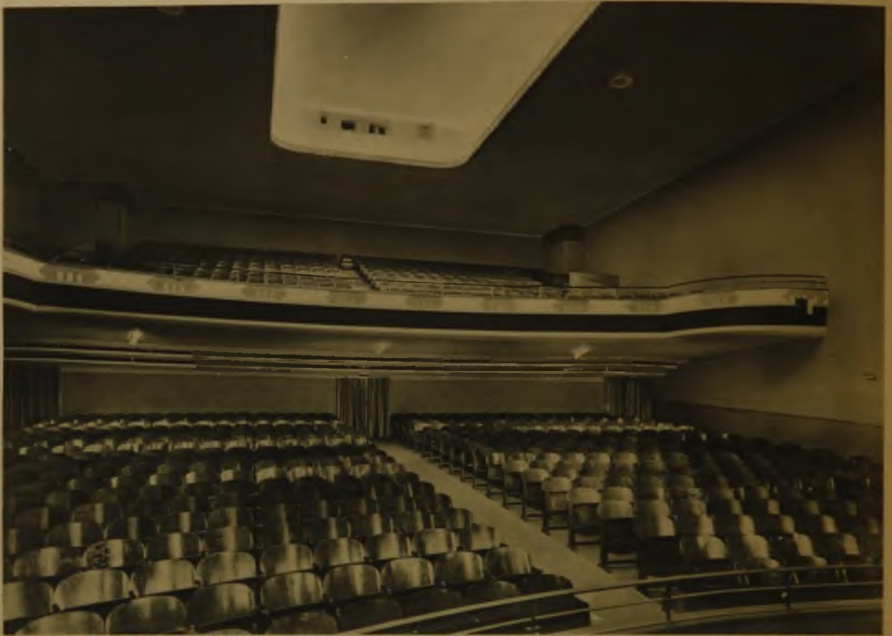
Innenansicht des Kinos, Baublock „Sterkrader Stadtmitte“
