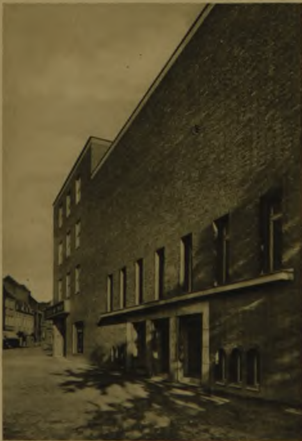
Baublock „Sterkrader Stadtmitte“ Kino-Nebeneingang
