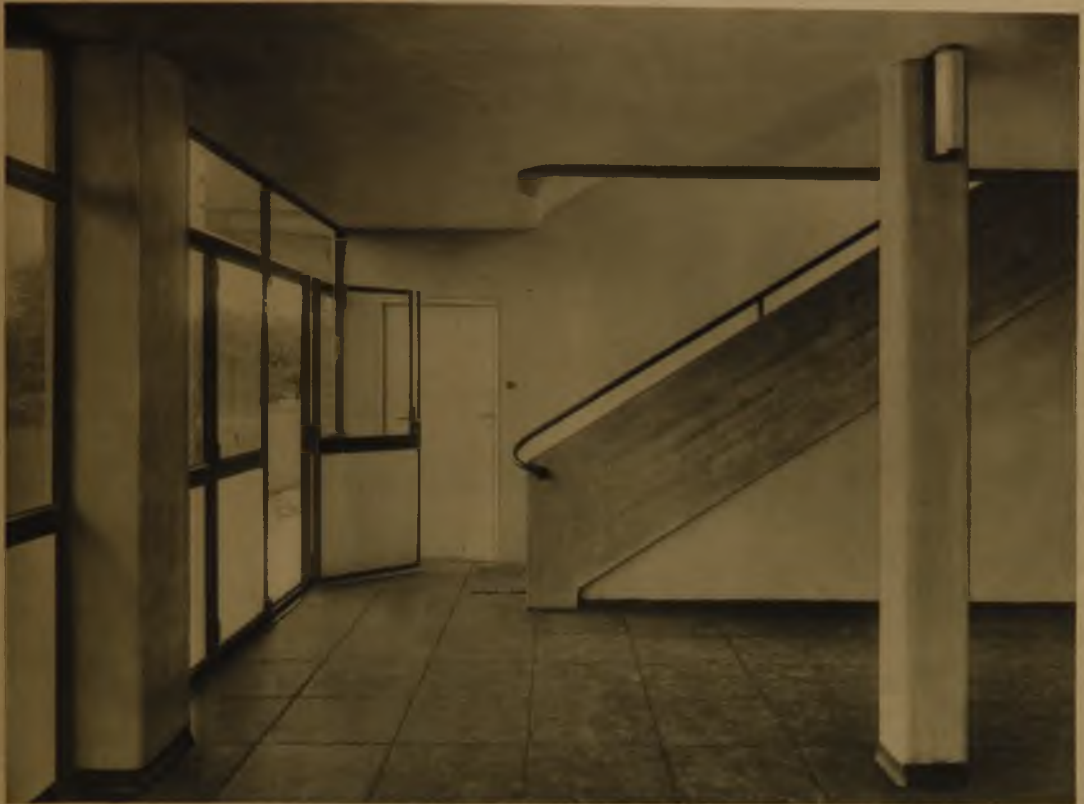
Eingangshalle mit gemeinsamem Treppenhaus in der Mitte des Baues
