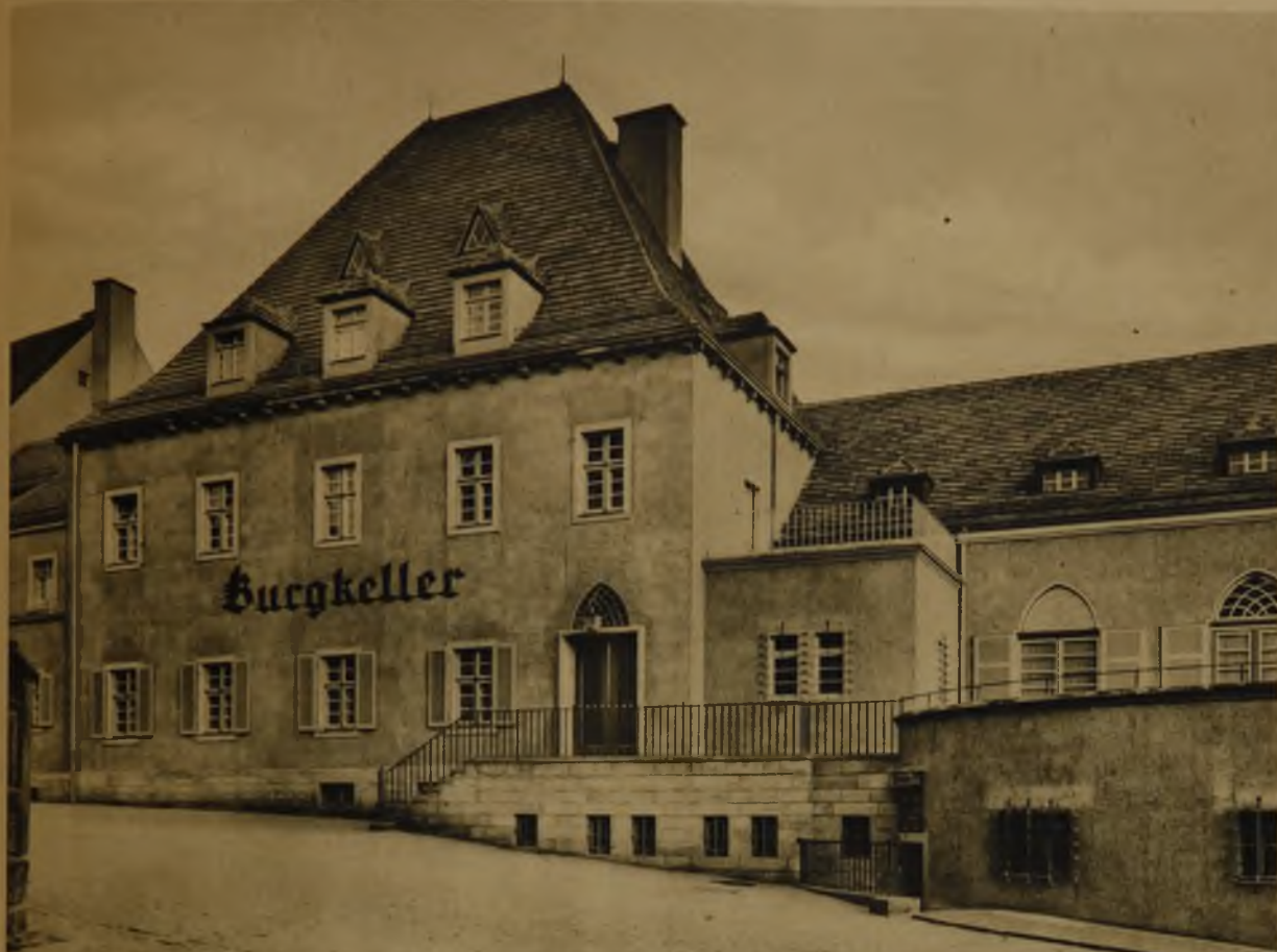
Ansicht am Domplatz
