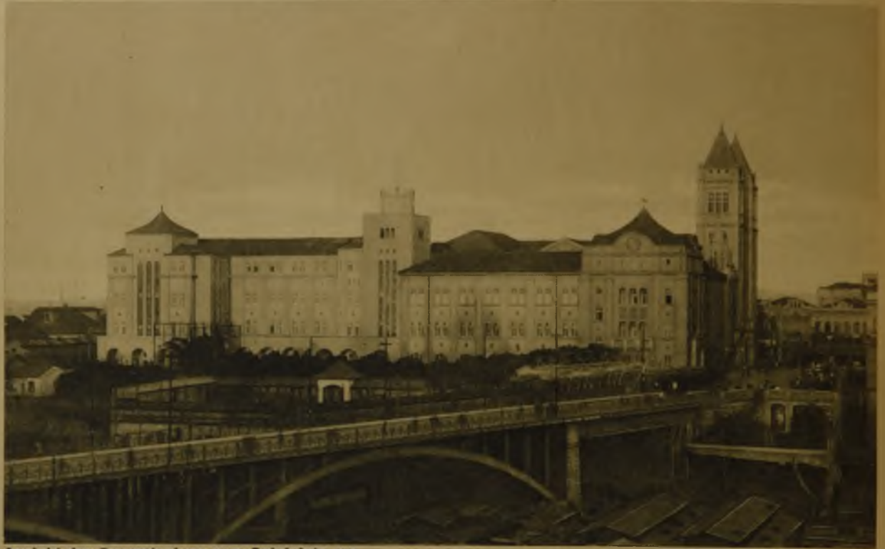
Ansicht der Gesamtanlage vom Spielplatz aus
