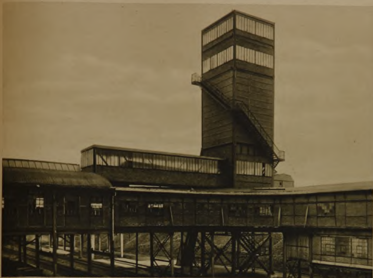
Bergetransportanlage mit Becherwerk (nicht sichtbar)
