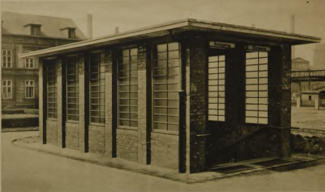
Eingang zu einer Unterführung
