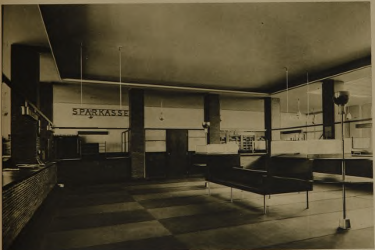
Ansicht der Kassenhalle
