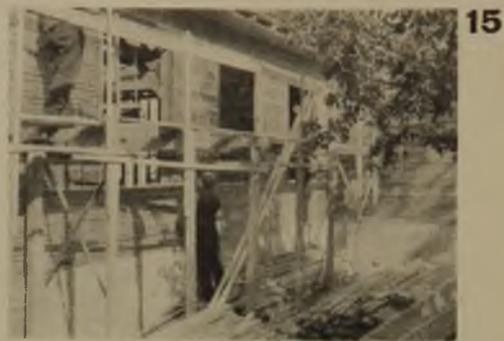
13-15. Holzskelettbau mit „Lapurus“-Putz. Wandstärke 15 cm, Ziegel-Flachdach, Wickelstakung in der Dachfläche.
