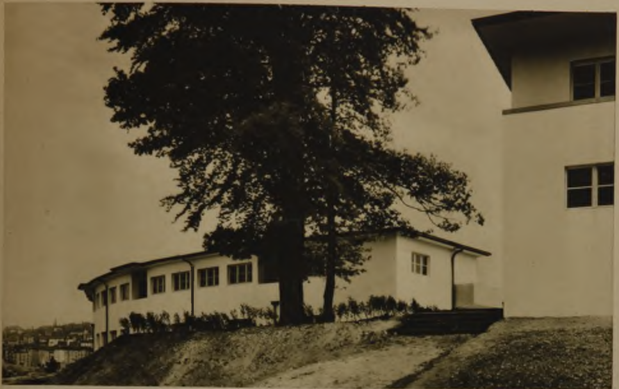
Siedlung für Leistungsschwache in Remscheid ARCHITEKT OBERBAURAT L. LEMMER, REMSCHEID
