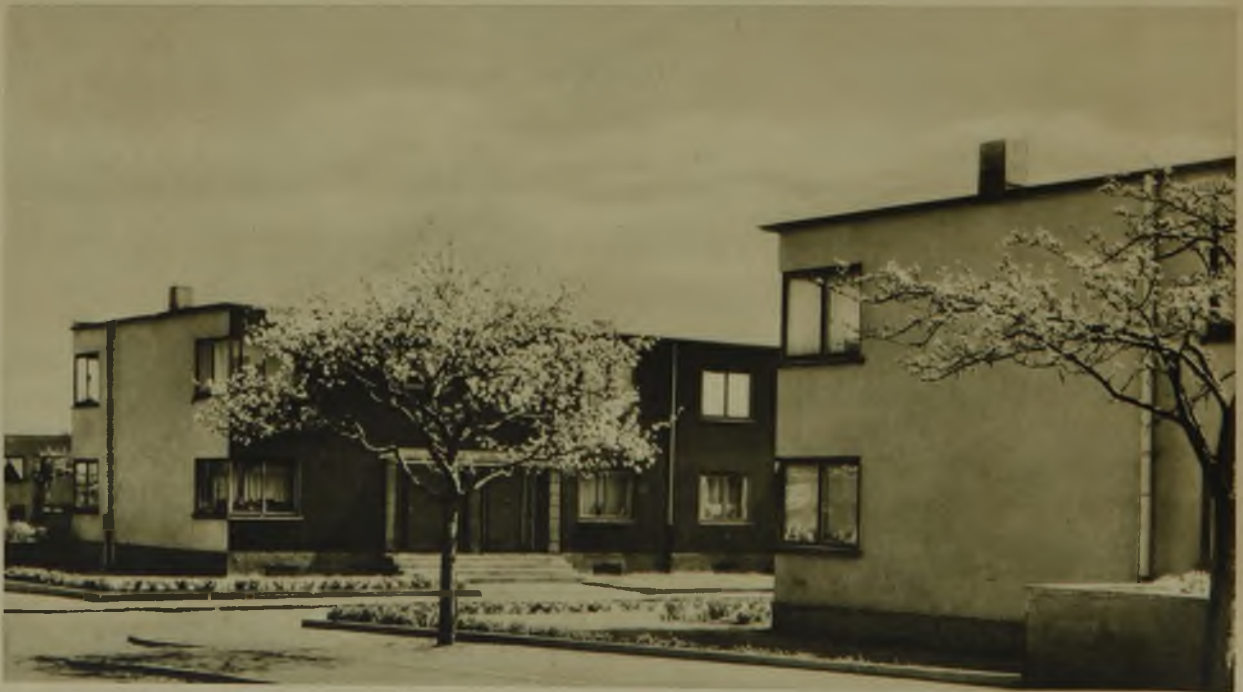
Straße „Am Forum“, Ecke „In der Römerstadt“. ARCHITEKT BDA RUDLOFF, FRANKFURT A. M.
