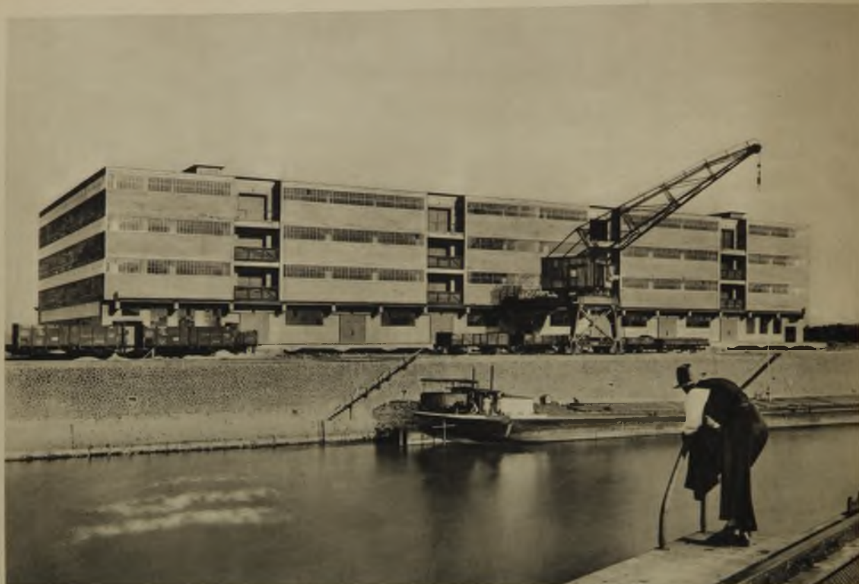
Lagergebäude im Hafen von Köln Gestaltung: Hans Mehrrens, Köln
