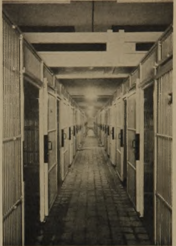
Fleischkühlraum mit vermietbaren Zellen. Umgitterungen aus Rundeisen hell in Emaillack gestrichen
