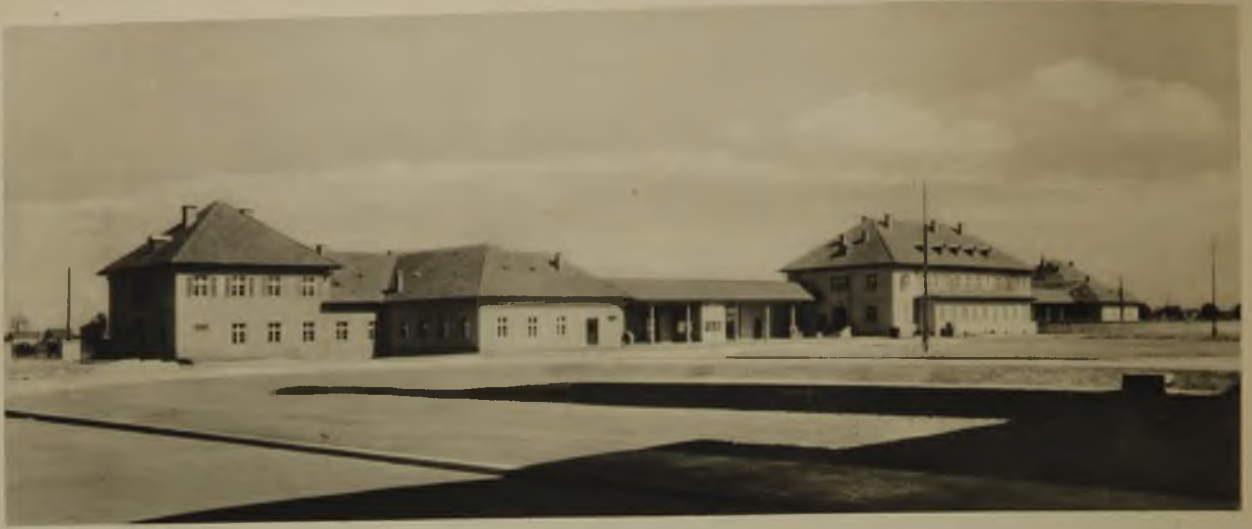
Hauptzufahrt, Verwaltungsgebäude und Gastwirtschaft
