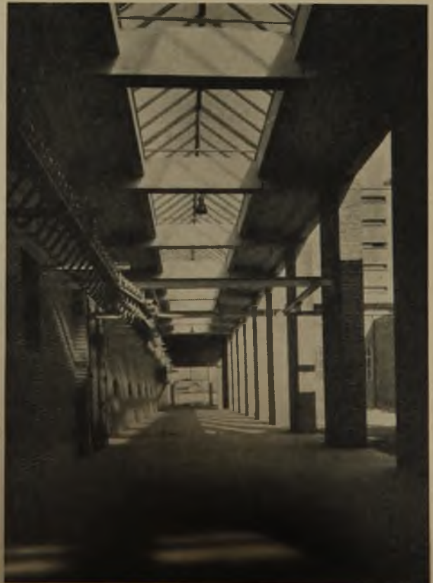
Betriebshalle am Kühlhaus. Förderschienen zur Fleischverkaufshalle
