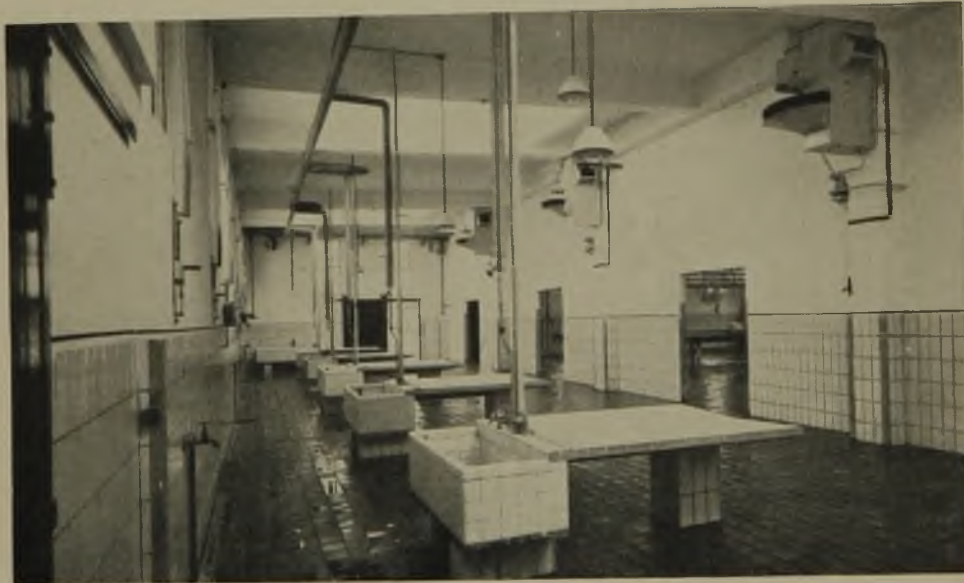
Schweinekuttel Fußboden gekuppelte Keramik- platten, Wandplatten hell glasiert, frostbeständig
