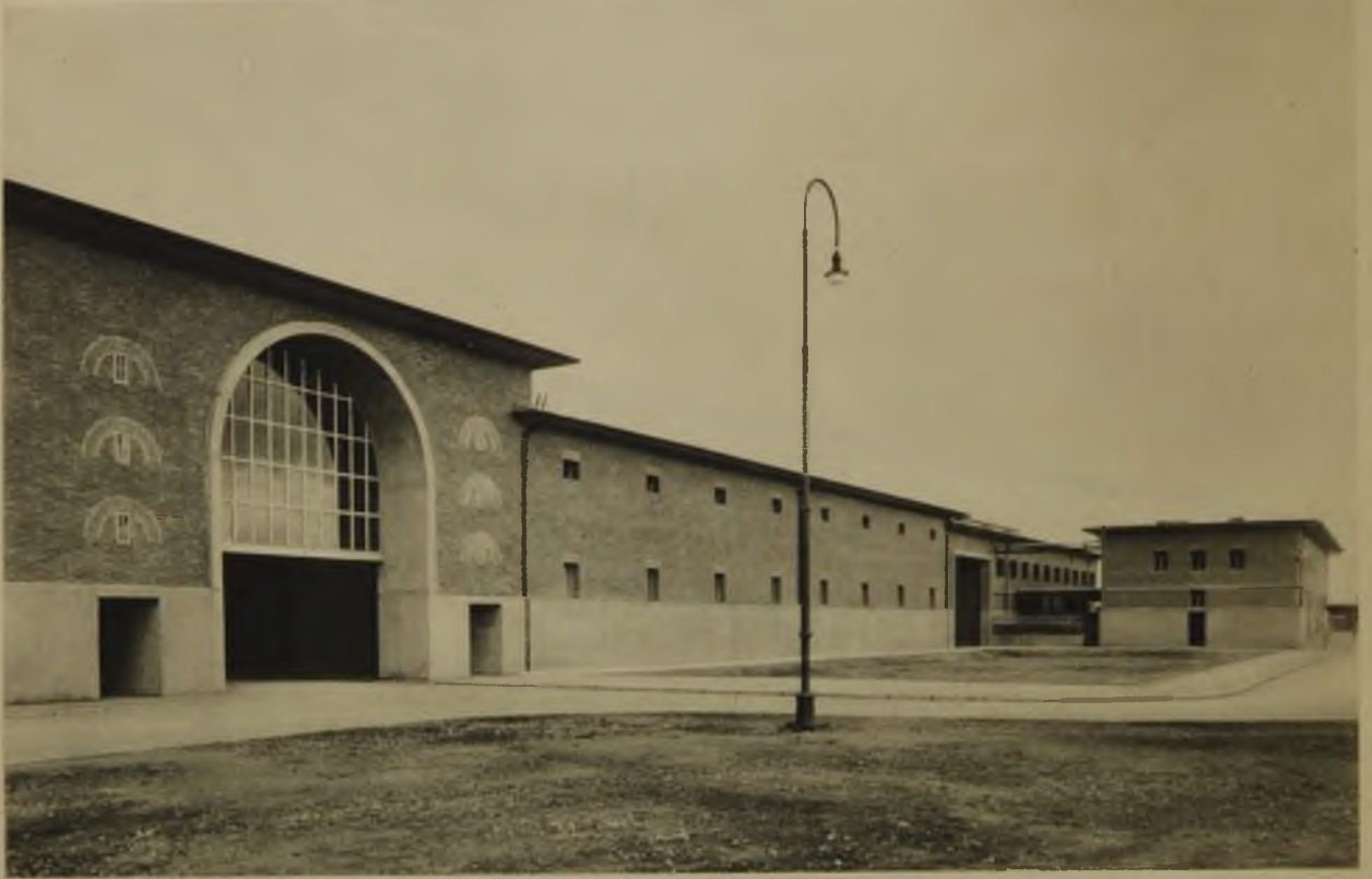
Süder der Abholhalle, Exportkühlhaus u. Schwelneschlachtstall. Die Betondächer laden weit über zum Schutz der Frontmauern. Die Fenster der Wohn- und Kühlräume sind in Holz, alle übrigen in Schmiedeeisen hergestellt
