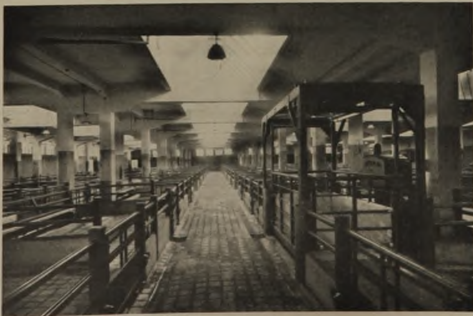
Kleinvieh- und Schweine- markthalle 2062 qm bebaute Fläche, Buchten glattgeputzter Zementtrabitz mit Gitter- aufsatz aus Gasrohr
