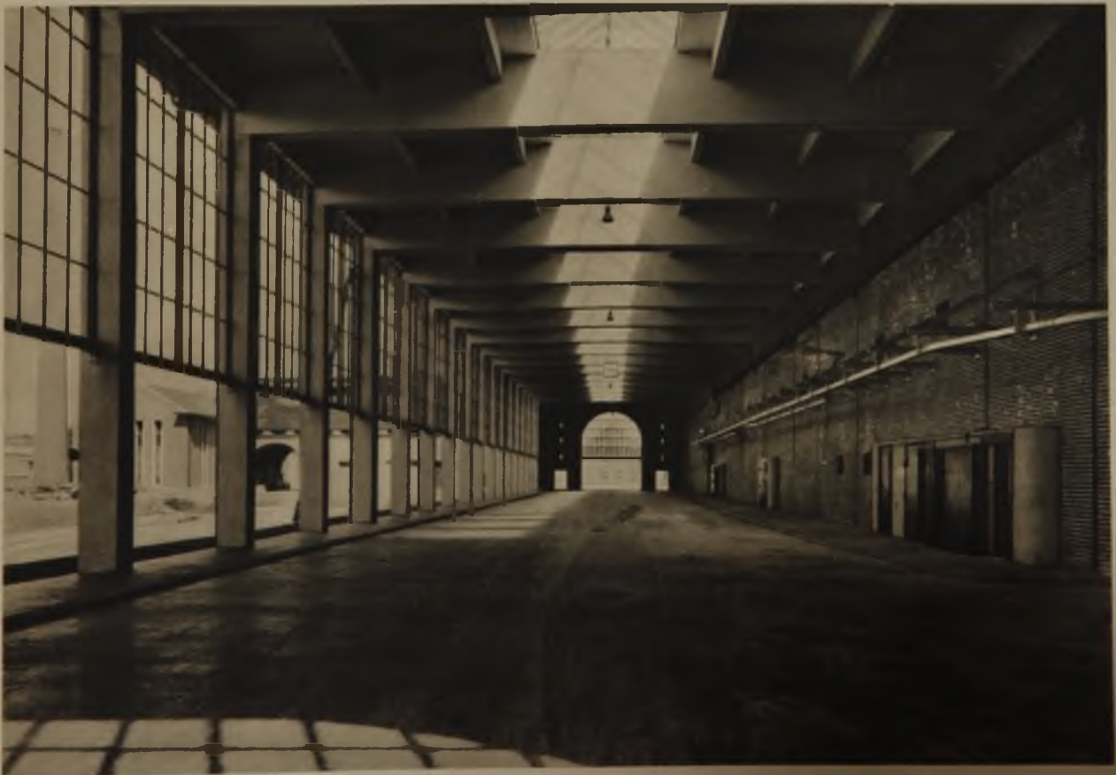
Inneres der Abholhalle. Breite 16 m bei 113,60 m Länge, Seiten- und Oberlicht.
