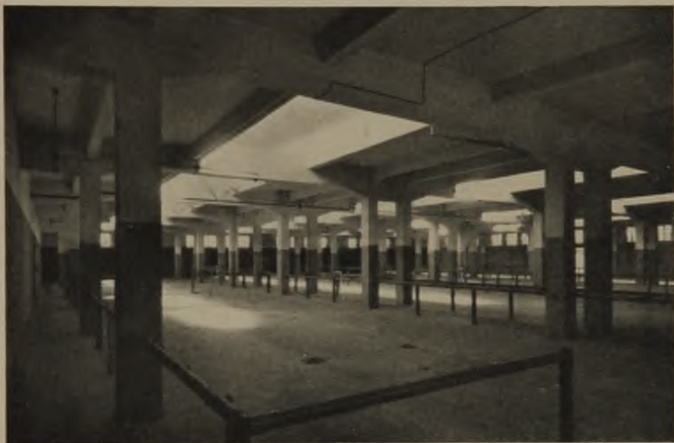
Markthalle für Großvieh 1630 qm bebaute Fläche, Reihenstände mit verzinktem Eisengitter
