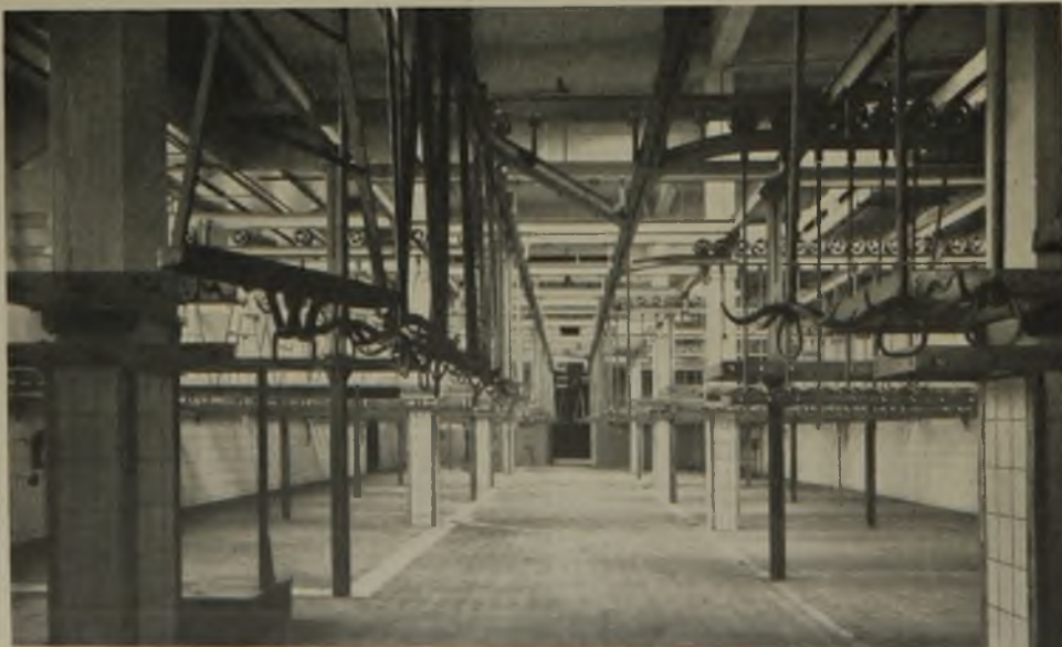
Verkaufshalle für Fleisch- großverkauf, Förderschiene mit Waage, Hakengerüste, Kühlvorrichtung
