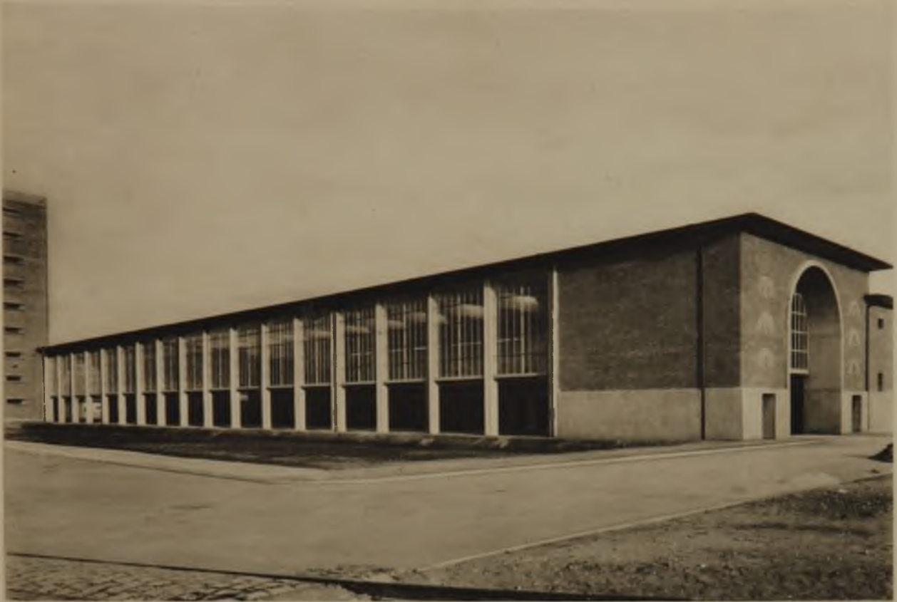
Ansicht der Abholhalle. Sockel in Kieselbeton bis über Reichhöhe, darüber Backsteine waagrecht gefügt. Pfeiler und Dach in Eisenbeton.
