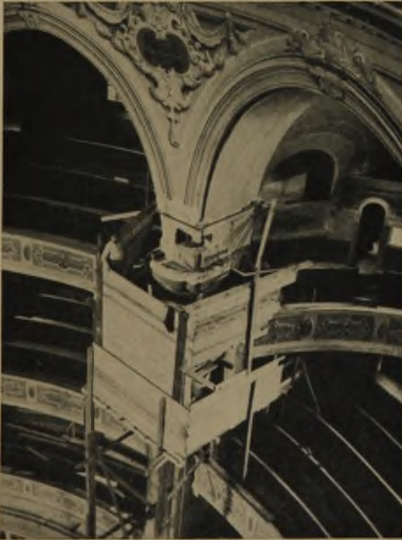
11 Auswechseln der zerdrückten Steine an den acht Kuppelfellern
