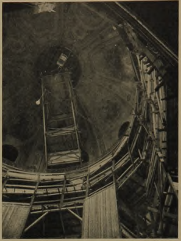
10 Dreh- und fahrbares Gerüst für die Innenkuppel
