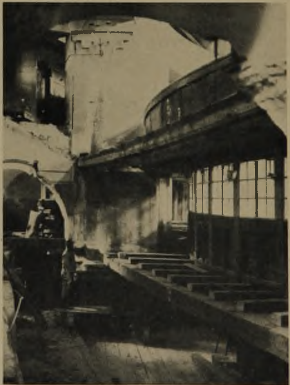
12 Erneuerung des Holzgebälks im Betstübchengeschoß
