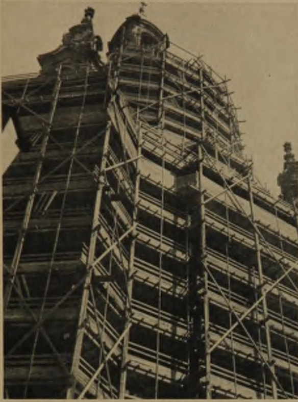
9 Außenrüstung für die Wiederherstellung
