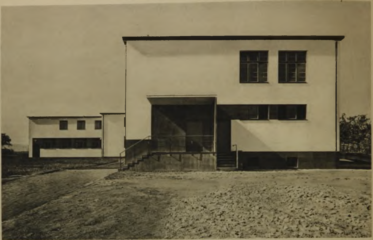
Ansicht von Osten. Links Ausgabe, rechts Annahme der Wäsche
