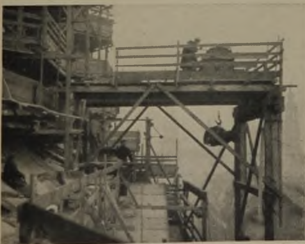
7 Wiederherstellungsarbeit am unteren Teil der Kuppel
