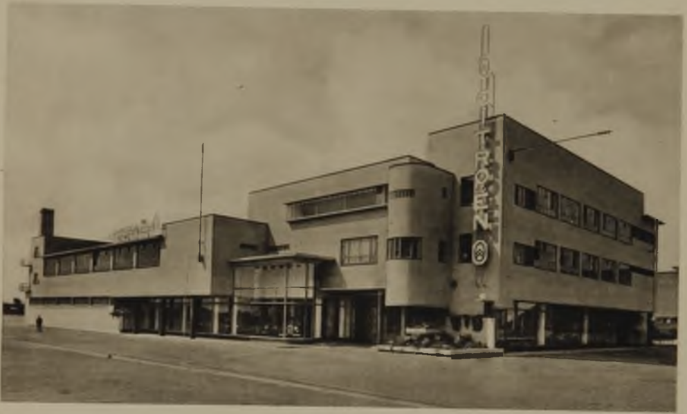
Citroën-Gebäude in Amsterdam Arch. Jan Wils, Voorburg
