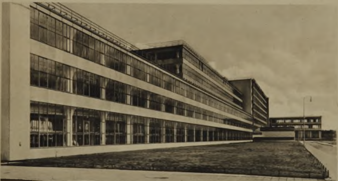
Rückseite der Fabrik „Van Nelle“ in Rotterdam. Arch. J. A. Brinkman und L. C. van der Vlugt
