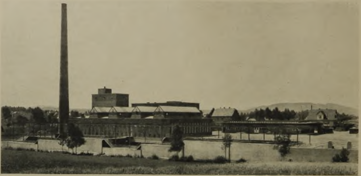
1 Übersicht über die Färberei-Anlage (Rechts Pförnerhaus und Garagen)
