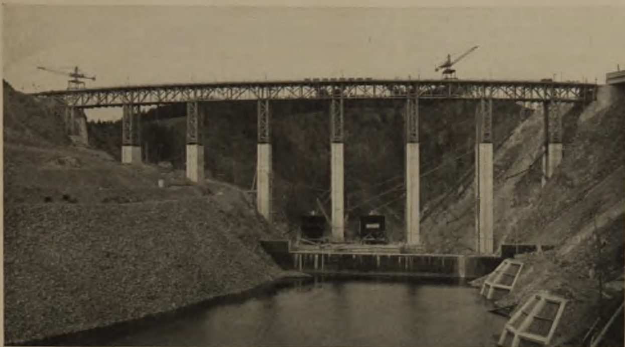
4 Die fertiggestellte Betonierbrücke (von der Hilfsmauer aus gesehen)
