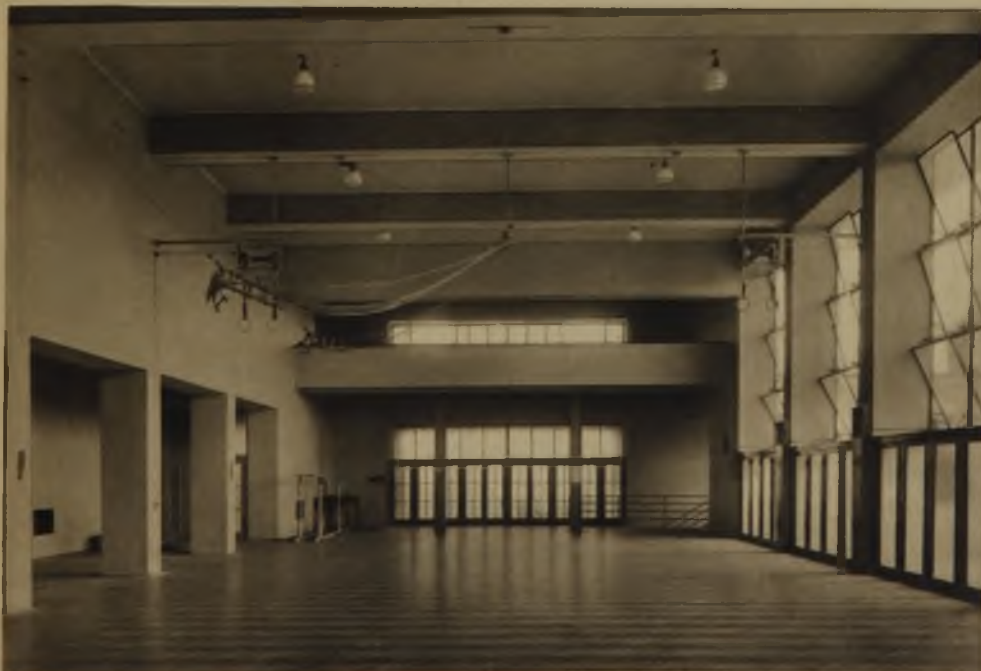
Turnhalle mit Blick gegen Eingang und Empore
