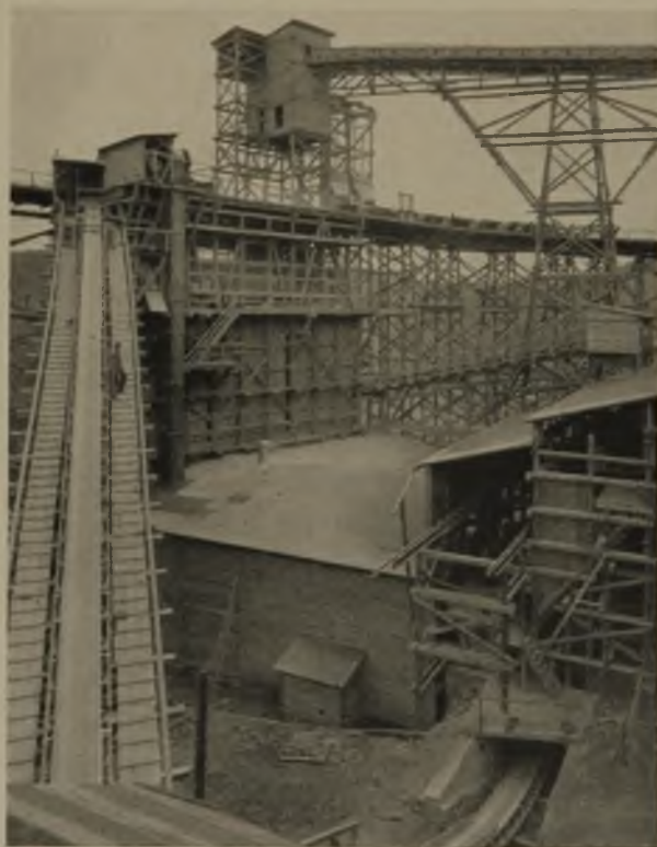
6 Mahlanlage für die Zuschlagstoffe
