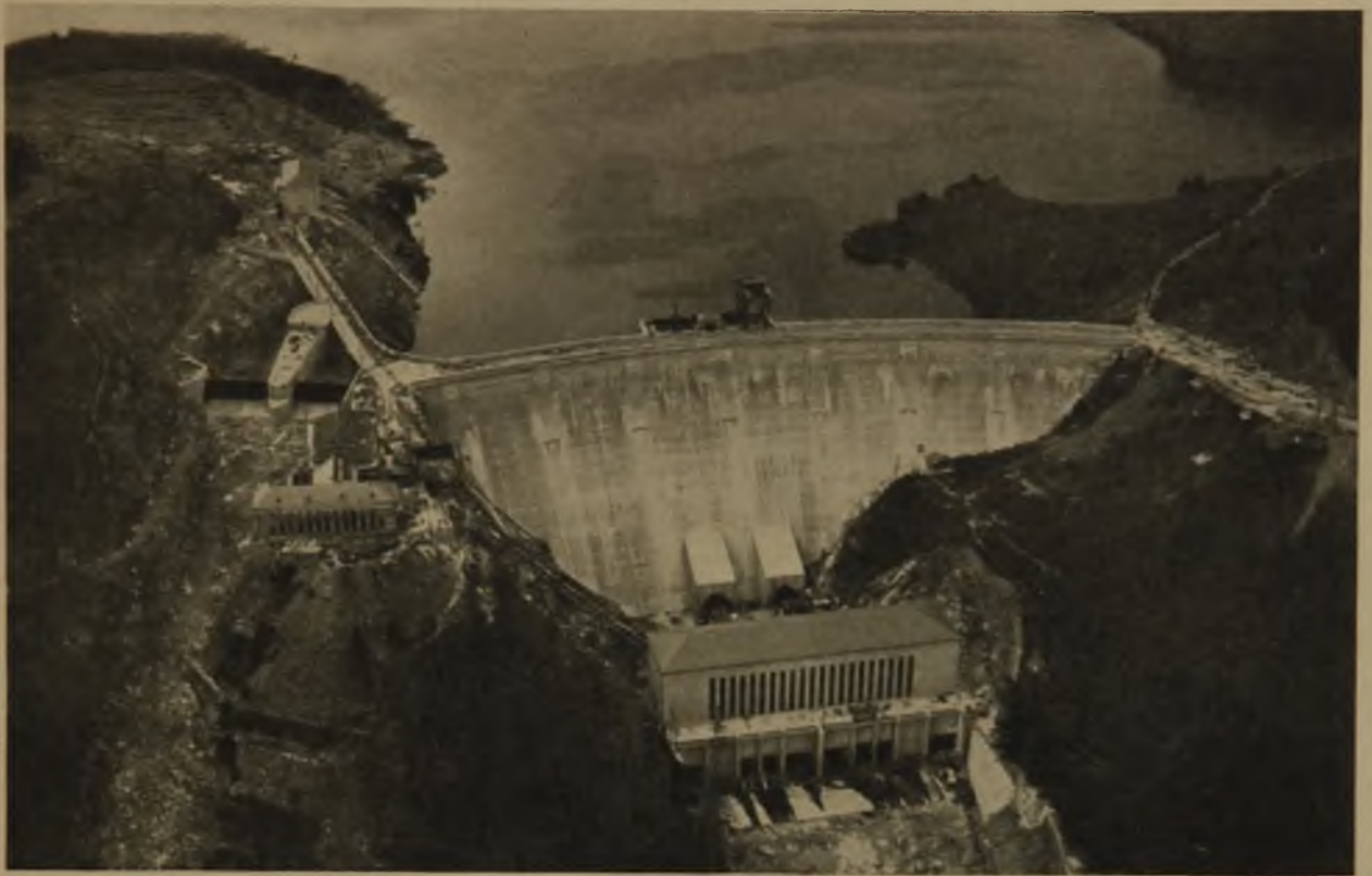
1 Die Bleilochtalsperre von unterhalb gesehen
