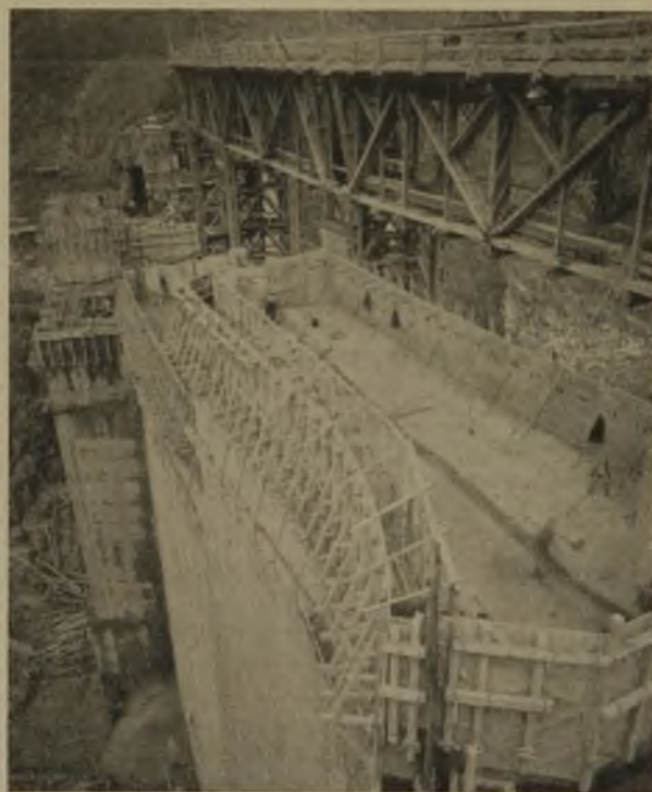
9 Hauptspermauer, Blick auf die Verschalungsarbeiten
