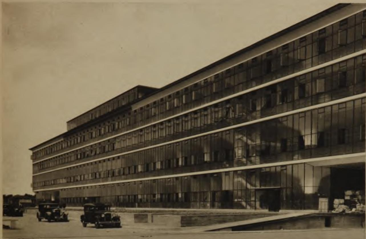
Hauptansicht der Fabrik. Der ganze Bau ist eine Eisenbetonkonstruktion mit Pilzdecken. Die Außenwand ist als Glas-Eisenhaut vorgehängt. Die Auflösung der Außenwand in Glas ist durch die großen Raumtiefen bedingt. (Foto „Building“)
