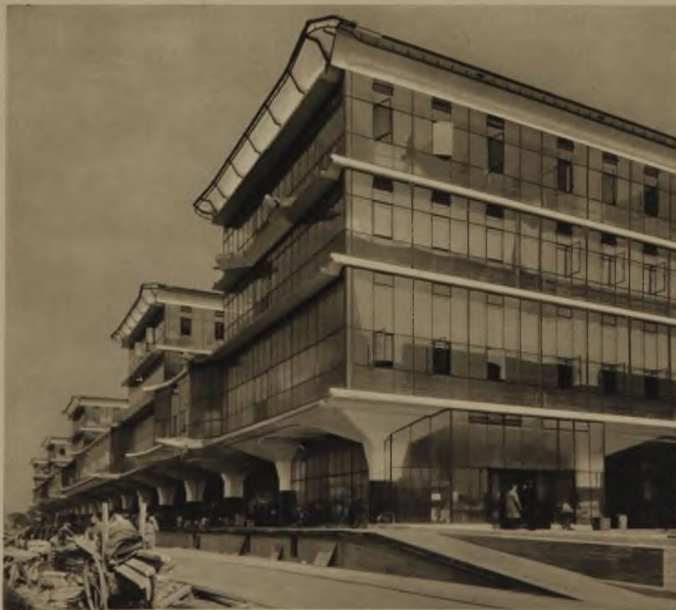
Ansicht von der Ladestraße. Die vorgesehene Erweiterung der Fabrik soll die Ladestraße überbrücken. Die Anschlüsse dazu sind bereits überall vorgesehen. Die für den großen Betonbau notwendigen Dehnungsfugen wurden an diese Stelle gelegt, um die spätere Erweiterung ohne Störung des Fabrikbetriebes vornehmen zu können. Die auskragende Laufschiene über dem Dachgesims dient zur Aufhängung des Wagens zur Fensterreinigung.
