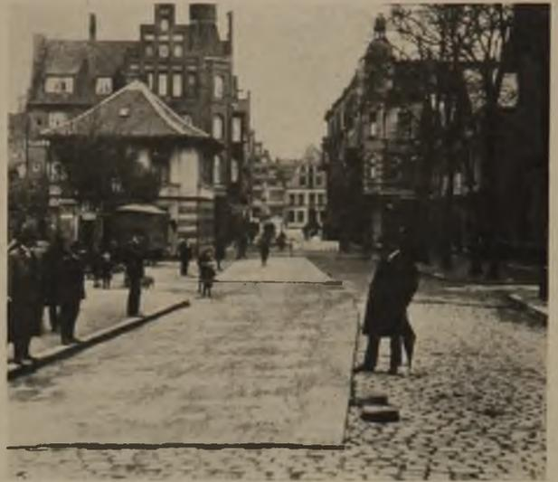
Rechts: Hartgußasphalt-Belag in zwei Schichten auf altem Steinpflaster
