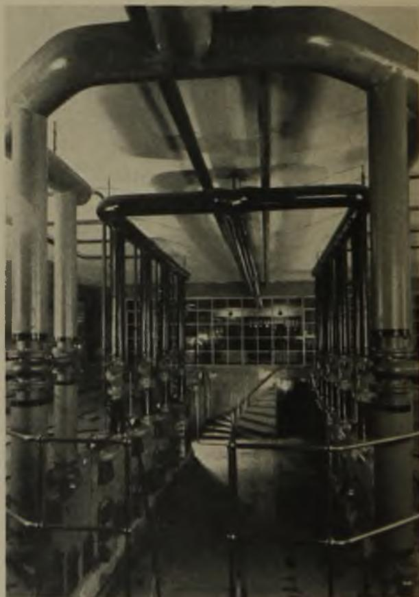
**Der Kesselraum für die Heizungs-, Warmwasser-, Be- und Entlüftungsanlage**
