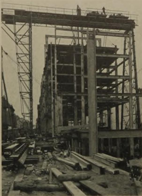
**Stahlskelettrahmenmontage mittels Brückenkran
