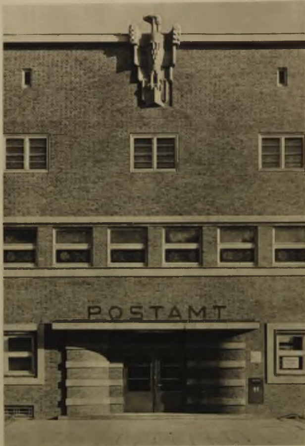
Mittelteil der Vorderseite des Gebäudes. Die Fenster der unteren Geschosse sind tiefliegend, jene des 2. Geschosses bündig versetzt, um der Außenseite ein stärkeres Relief zu geben. Baustoffe: Klinker, Muschelkalk und Bronze Aufnahme: Stickelmann, Bremen
