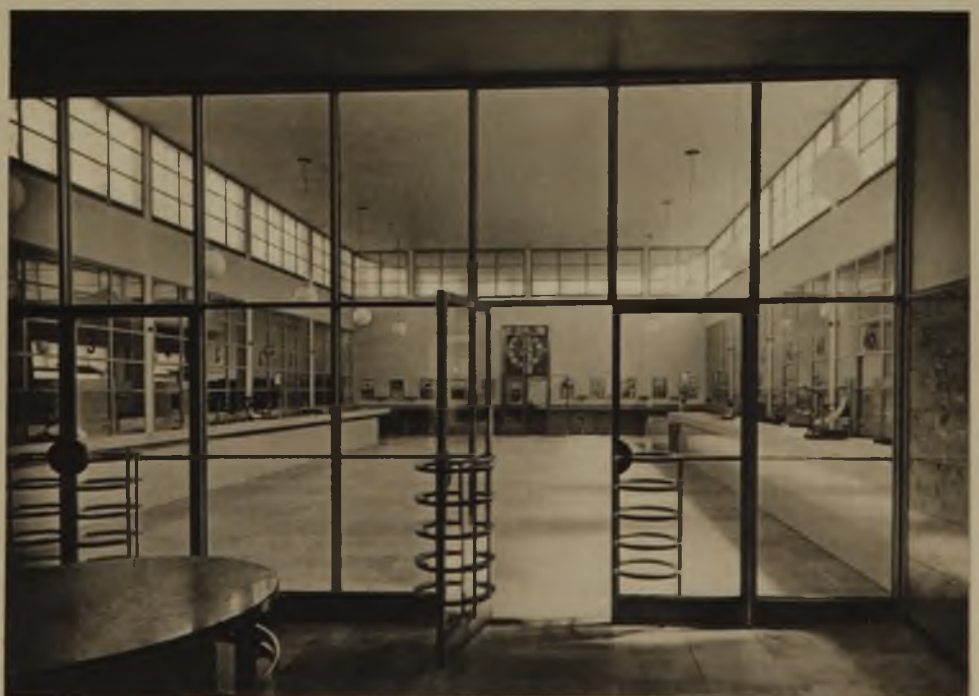
Schalterhalle vom Schließfachraum aus. Wände Muschelkalk, Bodenbelag Solnhofer Platten
