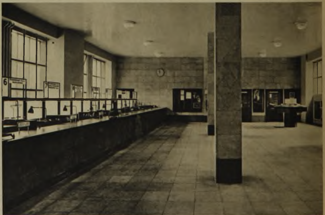
Schalterraum. Wand- u. Pfeilerverkleidung Muschelkalk, Boden Solnhofer Platten. Man beachte die Gestaltung der Tafeln an der rückwärtigen Wand
