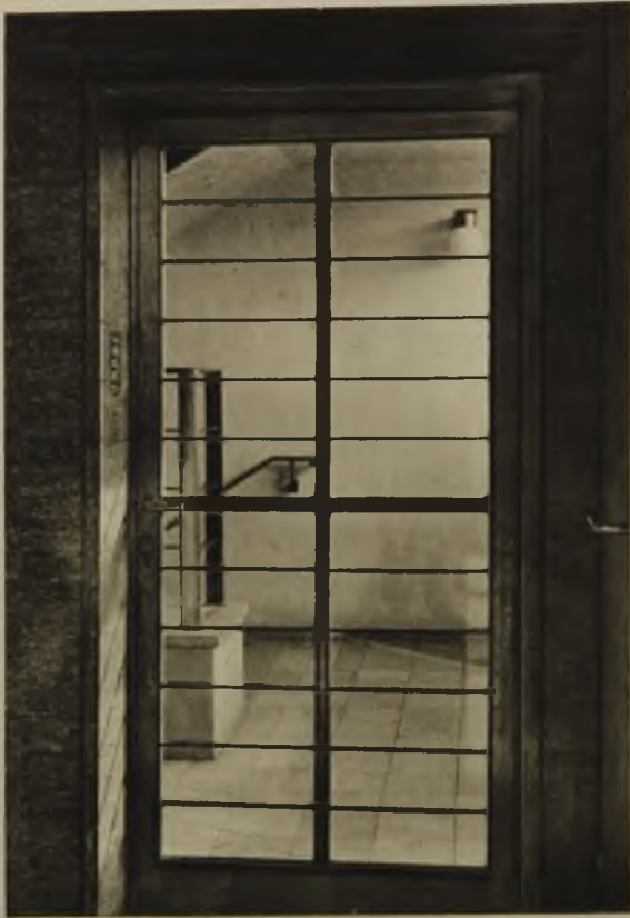
Tür von der offenen Halle zum Treppenhaus
