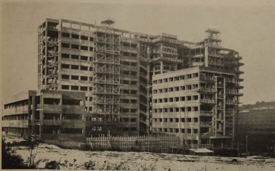
1 Vollendeter Rohbau (Nov. 1932)
