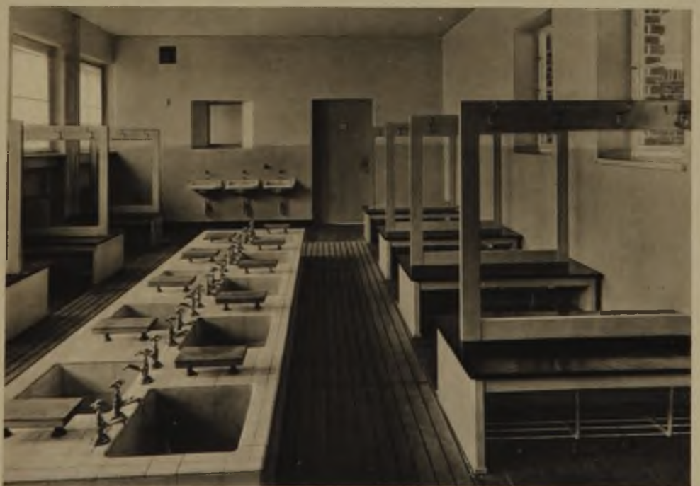
Umkleide- und Waschraum einer Turnhalle
