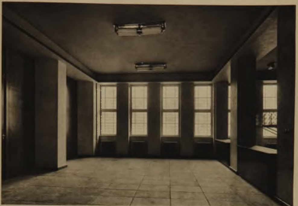
Aulavorraum mit Kleiderablage
