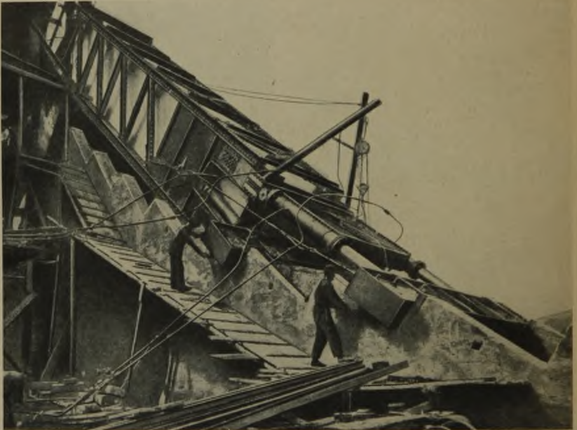
Anordnung der beiden Druckwasser-Pressen-Paare zur absatzweisen Hebung
