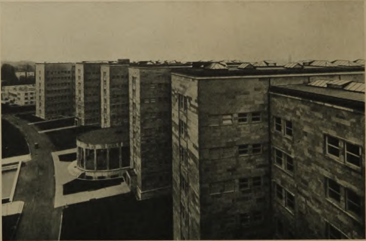
17 Verwaltungsgebäude der I. G.-Farbenindustrie A.-G., Frankfurt a. M. Dacheindeckung mit Tecuta-Bronze der Vereinigte Deutsche Metallwerke A.-G., Zweigniederlassung Hedderheimer Kupferwerk, Frankfurt a. M., Hedderheim
