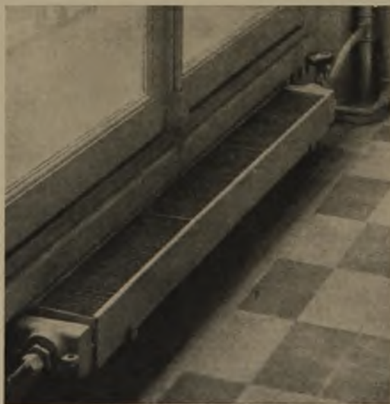
41 VDM-Heizkörper (Kupferrohre mit aufgesetzten Aluminiumlamellen)
