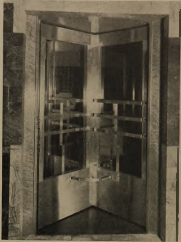
26 Drehtür aus massiver Bronze, ausgeführt von der Fa. Heinr. Kahl & Co., G. m. b. H., Aschaffenburg. Architekt Prof. Hoetger, Worpsswede
