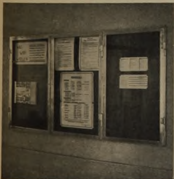
40 Anschlagtafel aus Silumin-Profilen. (Hersteller: Vereinigte Leichtmetallwerke G. m. b. H., Bonn)
