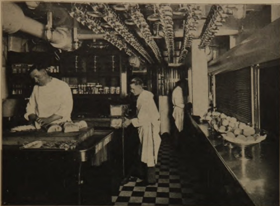
39 Küche des Schnelldampfers „Bremen“. Sämtliche Tische sind mit Monel-Metall belegt.
