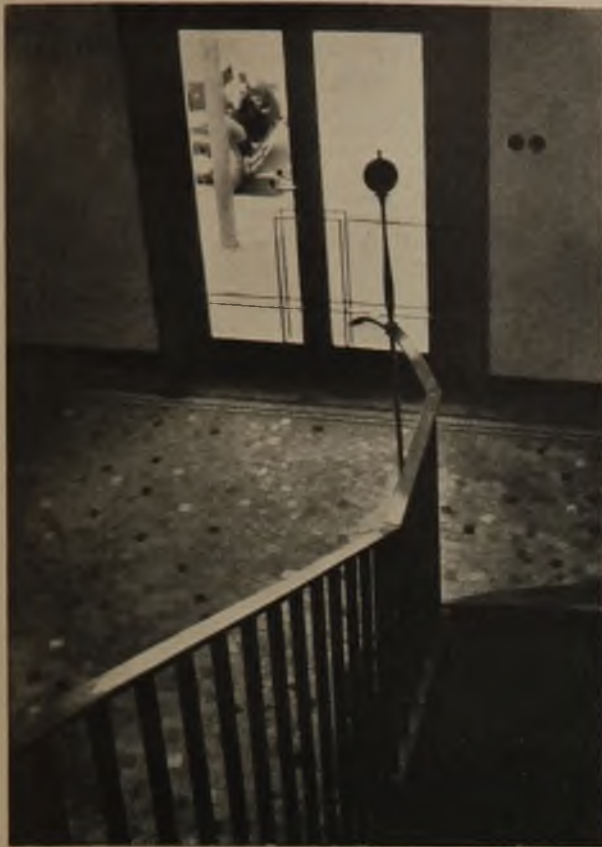
31 Neues Fernsprechamt, Memmingen (Bayern). Handlauf und Zierstäbe aus Wieselber der Fa. Wieland-Werke A.-G., Ulm, Donau. Türe im Hintergrund aus massiv Delta-Metall
