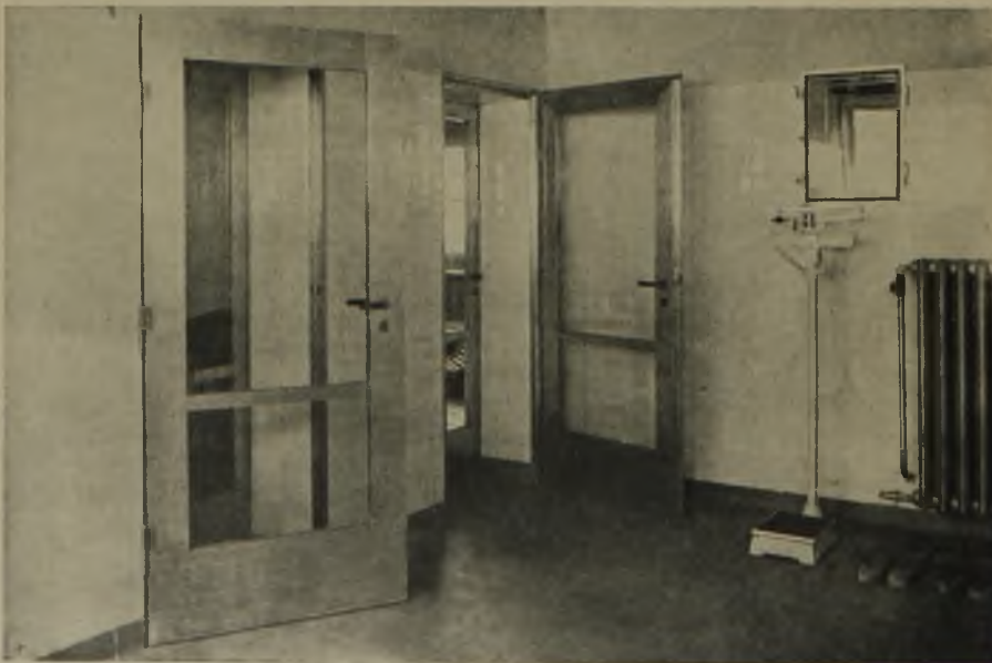
38 Städt. Schwimmbad Frankfurt a. M. Dampfbaderaum mit Türen aus Silumin
