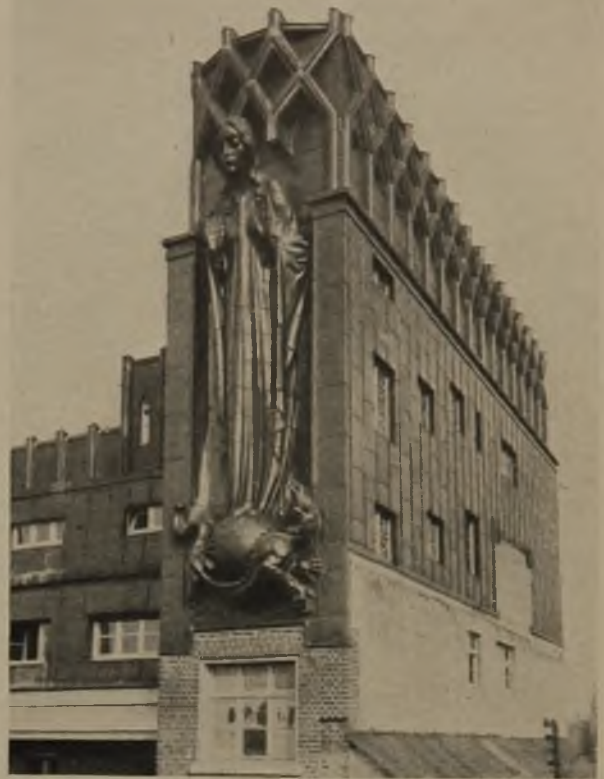
3 St. Raphaels-Klinik in Münster (Westf.) Architekt: Reg.-Baumstr. Dipl.-Ing. C. Brocker, Düsseldorf. Dach und Außenwände mit Kupferblech von 0,7 mm Dicke bekleidet. Auch hier war möglichst leichte Bauweise notwendig, wobei als Schutz gegen Witterungseinflüsse der Metallbelag dauerhaft und zuverlässig dient. Die neuartige, riesige Metallplastik unterstreicht die eigenartige Wirkung des hochaufstrebenden Baues
