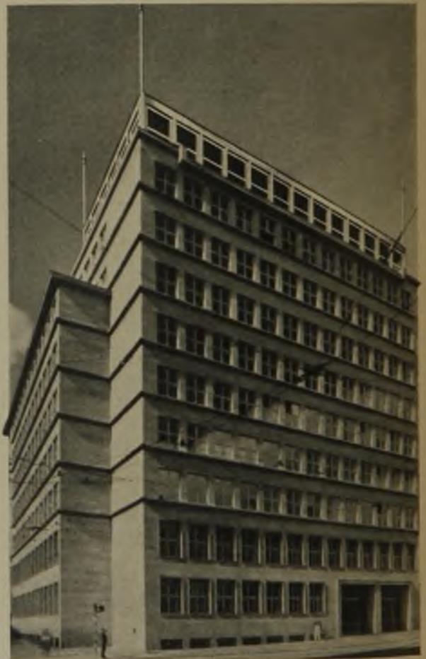
2 Hochhaus der Stadt. Sparkasse, Breslau. Oberstes Stockwerk an Fassade, Fensterblechen, Brüstungsgeländer und Fahnenstangen mit 1,5 mm starken Reinnickelblechen verkleidet. Das weiße Metall entspricht der übrigen hellen Farbe des Baues und besitzt eine außerordentlich hohe Witterungsbeständigkeit und damit Lebensdauer
