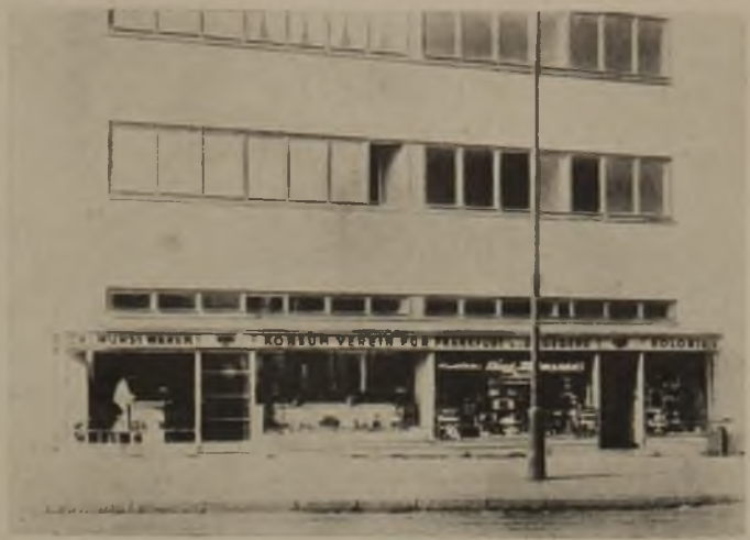
11 Verkaufsläden mit Schaufensterrahmen und Türkonstruktion aus Leichtmetall der Vereinigte Leichtmetallwerke G. m. b. H., Bonn
