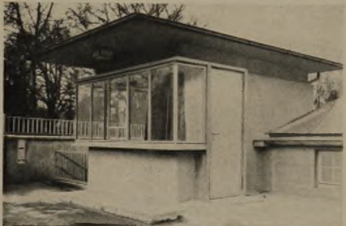
12 Portierhaus im Hof des Verwaltungsgebäudes der Metallgesellschaft A. G., Frankfurt a. M. Tür- und Fensterrahmen sind in Silumin ausgeführt
