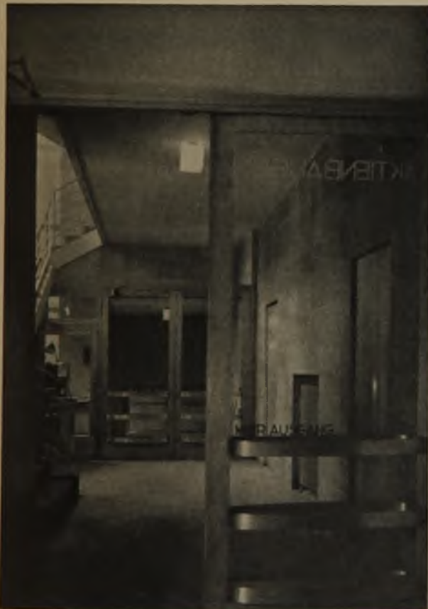
27 Vorraum mit Türen, Türzargen usw. aus Leichtmetall der Vereinigten Leichtmetallwerke, Bonn
