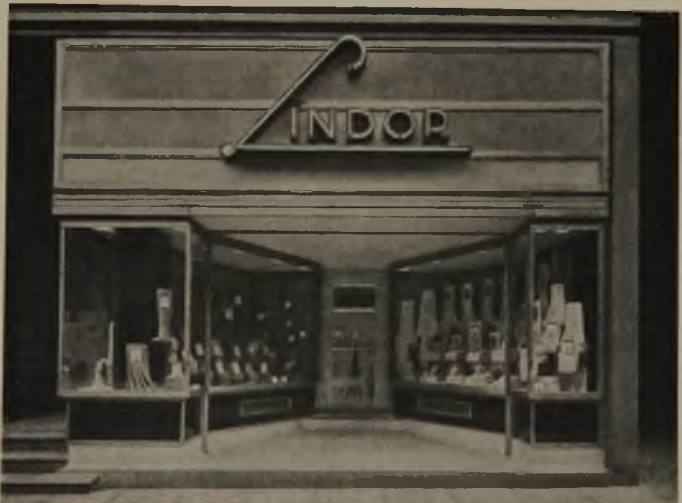
13 Ladenfront Lindor in Hamburg. Buchstaben und Fensterprofile in Monel-Metall
