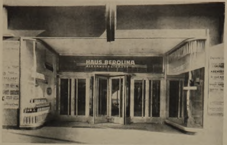
21 Portal des Hauses Berolina, Berlin, Alexanderplatz. Ausführung in Bronze der Fa. Kreidlers Metall- und Drahtwerke, Zuffenhausen bei Stuttgart
