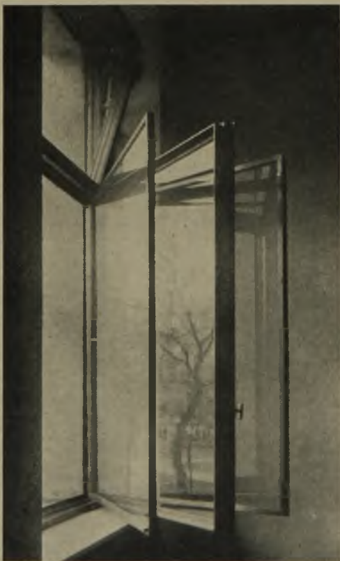
20 Arbeitszimmer des Reichskanzlers im Neubau der Reichskanzlei in Berlin. Einflügeliges Fenster mit Kippflügel in massiver Bronze für 3fache Verglasung (in einem Flügel aufeinanderliegend). Sämtliche Bänder und Verschlüsse unsichtbar eingebaut. Hersteller Paul Marcus, Eisen- und Bronzebau, Berlin-Schöneberg
