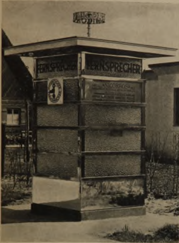
25 Fernsprechezelle aus Nicorros auf dem Freigelände der Deutschen Bauausstellung, Berlin 1927. Nicorros ist eine dem Monel-Metall ähnliche Kupfernicker-Legierung der Vereinigten Metallwerke A.-G., Zweign. Basse & Selve, Altena (Westfalen)
