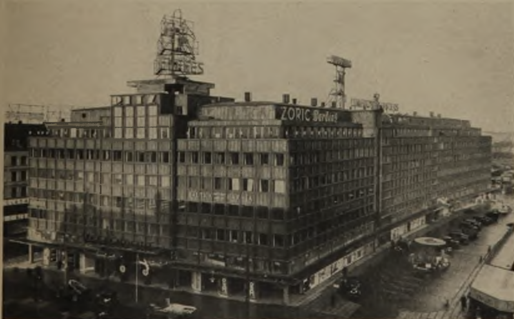
4 Haus Vesterport in Kopenhagen. Architekt Ole Falkentorp, Kopenhagen. Dach und Außenwände mit Kupfer bekleidet, insgesamt 15 000 qm
