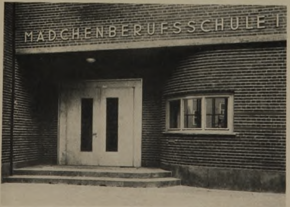
23 Eingangstüre aus Silumin der Vereinigten Deutschen Leichtmetallwerke, Sonn a. Rh. — Siluminblech auf Holz aufgeklebt
