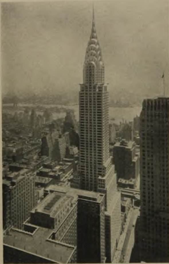
1 Chrysler-Gebäude, New York, mit Nirosta-Verkleidung der Ladenfronten und der Fensterrahmen der unteren Stockwerke; ferner Bedachung des 88 m hohen Turmes, sowie viele Teile des Innenausbauens aus Nirosta
