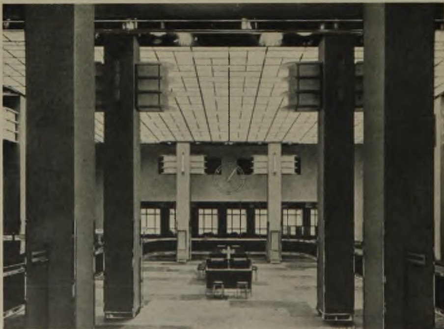
30 Städtische Sparkasse, Essen, Schalterraum. Beschlagteile, Glasfassungen usw. aus Nirosta. Entwurf: Prof. Metzendorf und Baurat a. D. Schneider, Essen
