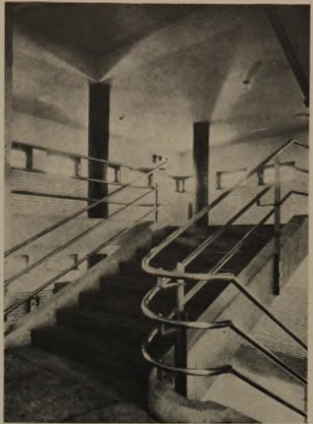
32 Realgymnasium Wiesdorf. Treppengeländer aus Duran-Silber der Dürener Metallwerke A.-G., Düren, Rhl. Architekt Fäbber, BDA., Kuppersteg bei Köln
