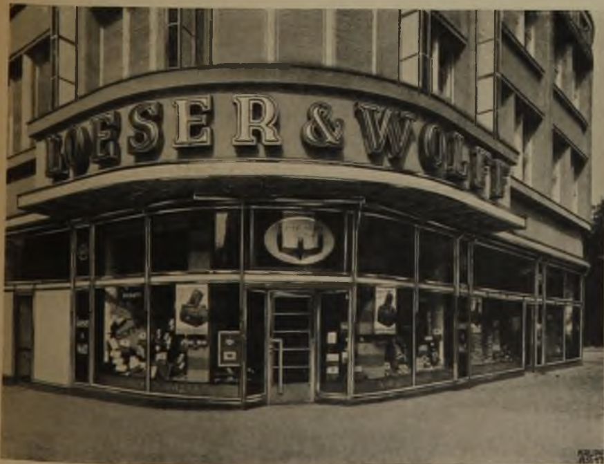
8 Ladenfront des Hochhauses Loeser & Wolff, Berlin. Schau- fenstereinfassungen, Türen, Leucht- bänder usw. sowie Baldachin aus Nirosta. Arch. Alb. Biebendt, Berlin
