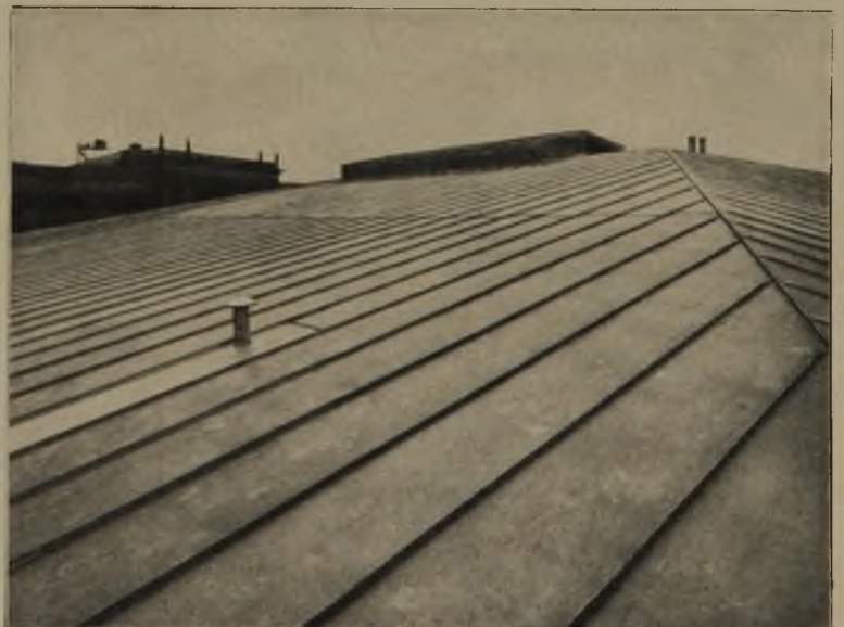
19 Technische Hochschule Berlin-Charlottenburg. Dacheindeckung mit Legierung AW 15 der Aluminiumwalzwerke Singen. Blechstärke 0,7 mm
