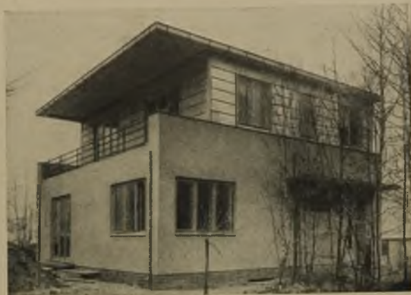
5 Wohnhaus in Frohnau bei Berlin. Außenwände des Obergeschosses mit Zinkbändern von je 30 cm Breite bekleidet, in wagrechten Streifen zur Traufe verlegt. Architekt BDA Ludewig, Berlin
