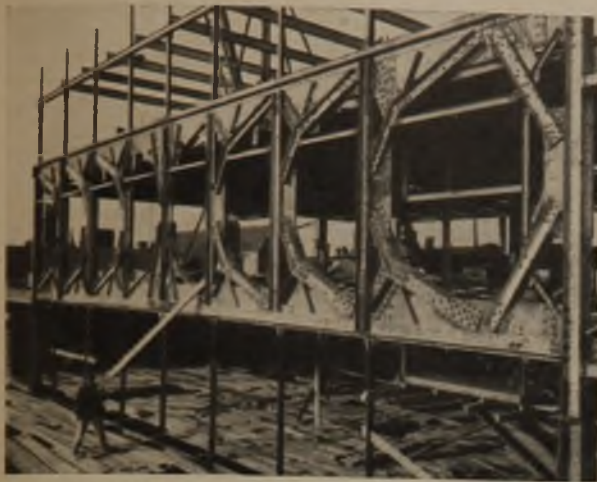
10 Abfangträger im Altersheim
