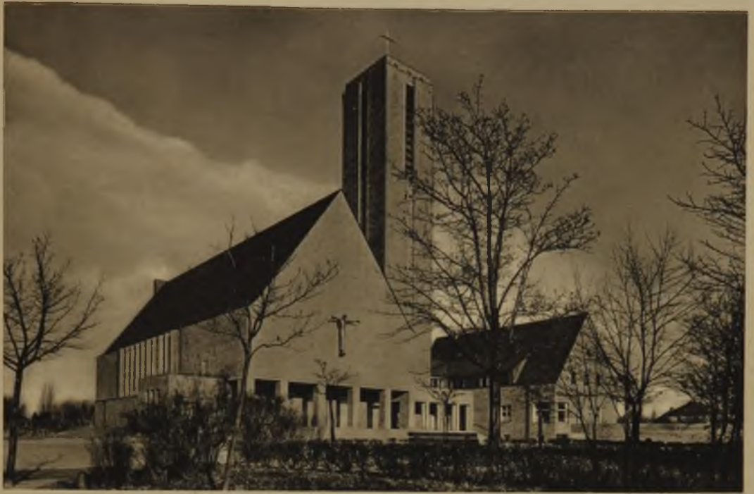
Eingangsseite von Süden aus gesehen, rechts Pfarrhaus
