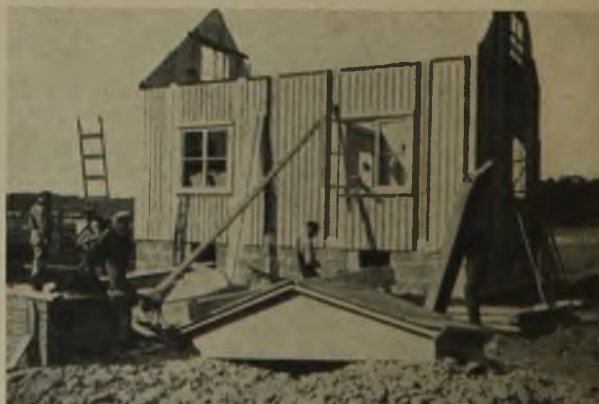
2 Kleinhaus der Stadt Stockholm im Bau
