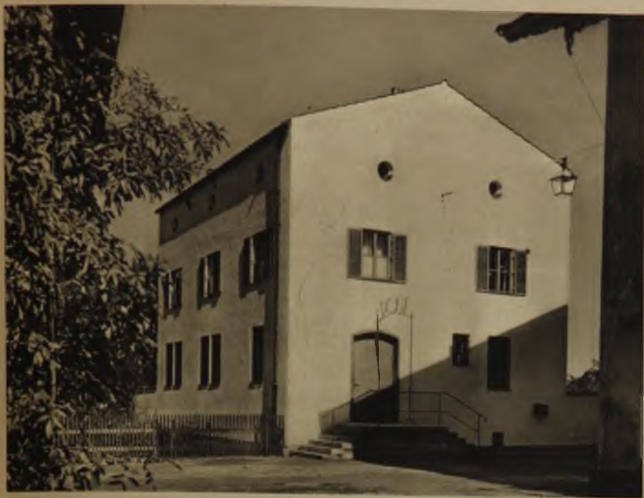
Postdienstgebäude in Grassau (Oberbayern). Bewußtes Abweichen vom Bauernhaustyp, der wegen der geringen Breite und Tiefe des Hauses nicht gewählt werden konnte, ohne dem Gebäude etwas Kindisches zu geben; dafür Erhöhung mittels Kniestock, um dem Gebäude als Amtsbäude Geltung zu verschaffen
