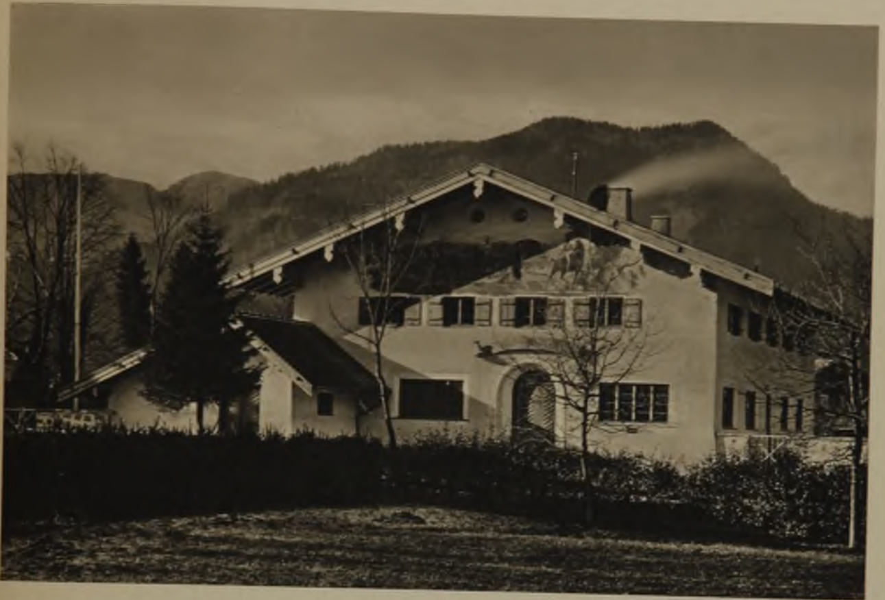
Postdienstgebäude in Rottach. Die Übernahme des reinen Bauernhaustypes auf ein Postdienstgebäude war ein Versuch, der aber in wirtschaftlicher (notwendige Breite — großer Holzverbrauch) und hygienischer Hinsicht (ungünstige Besonnung von Wohnungsteilen im Obergeschoß) nicht vorteilhaft war
