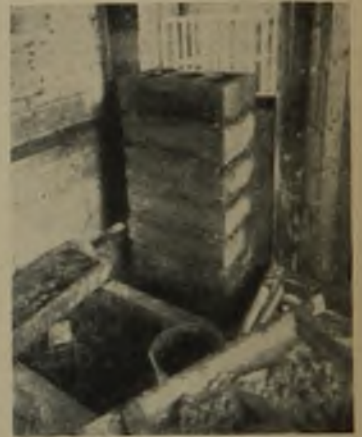
9 Aufbau der Schornstein-elemente aus Gasbeton
