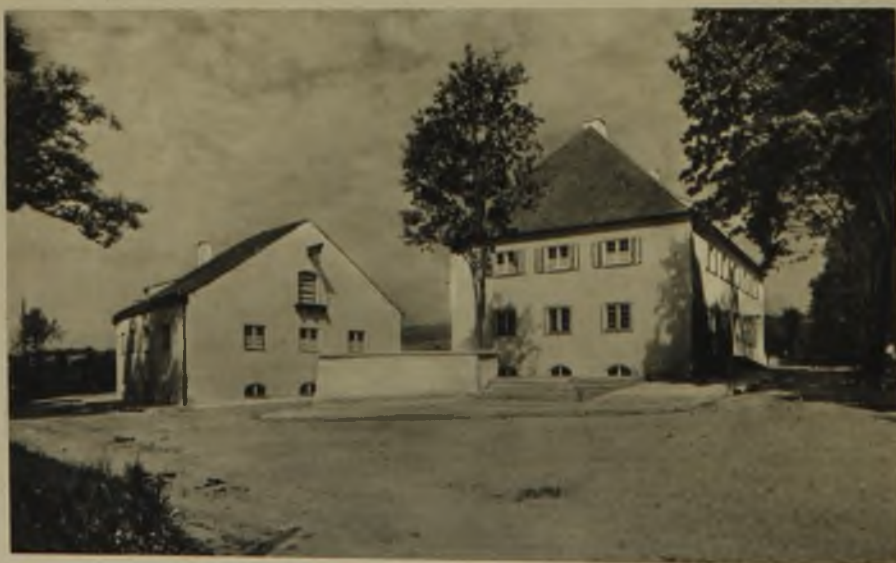
Postdienstgebäude in Pfarrkirchen. Ungezwungene Einfügung in das Landschaftsbild, Überleitung der Bauten in die Landschaft mittels verbindender Mauern, breiter Stufenanlage und Bepflanzung
