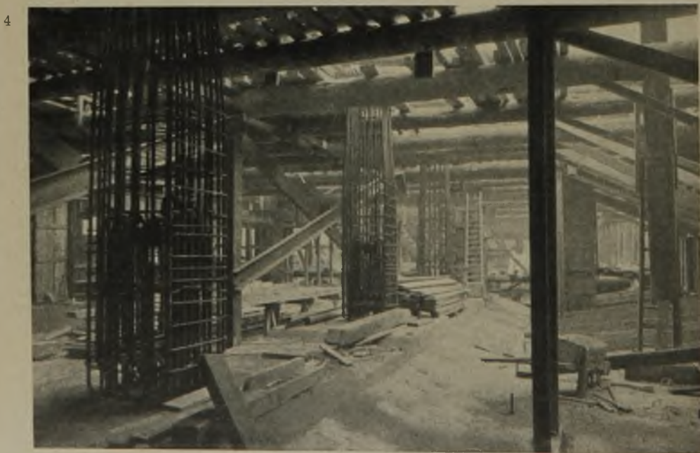
4 Blick in den unteren Keller bei Herstellung der Eisenbetonstützen
