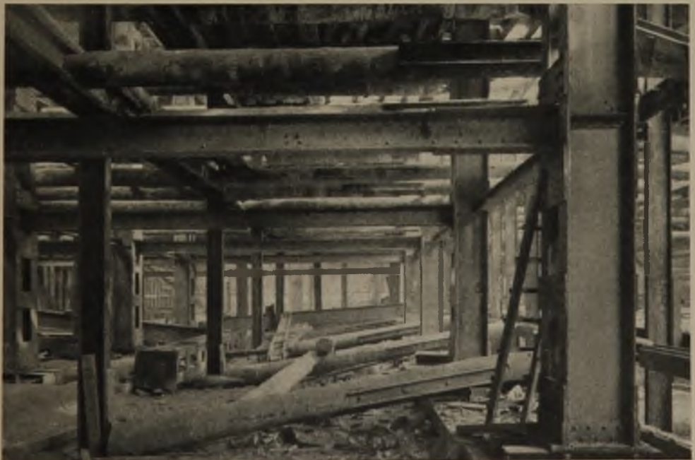
14 Untere Geschosse in Stahlskelettbau in Mon- tage
