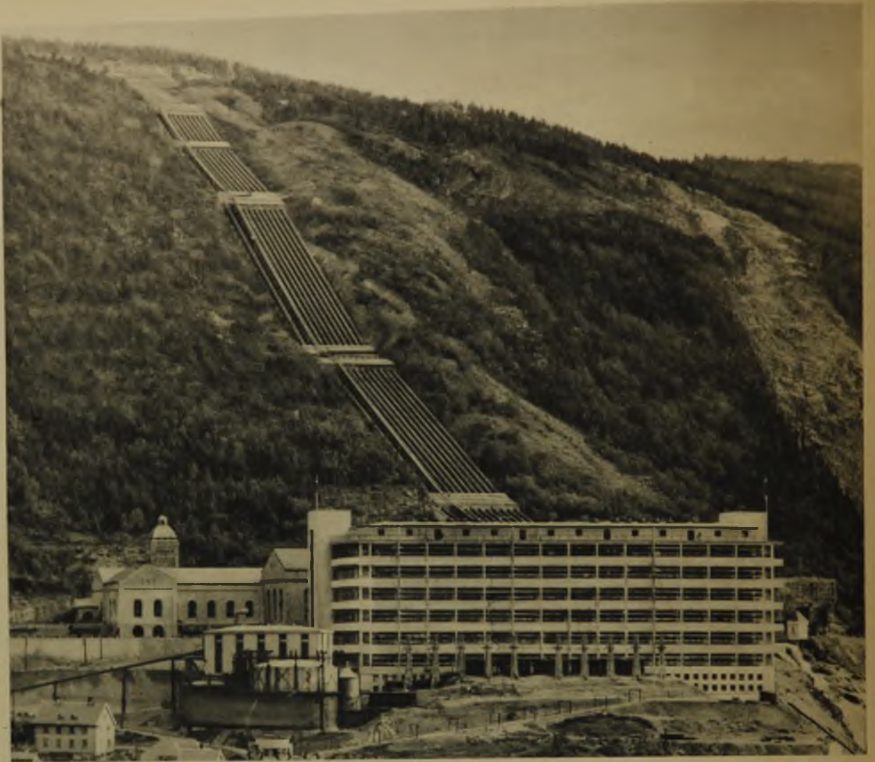
Wasserstoffwerk Rjukan. Der siebengeschossige Bau ist eine reine Eisenbetonkonstruktion mit Pilzdöcken; er hat eine Gesamtlänge von 110 m, eine Breite von 21 m und eine Höhe von 36 m. Architekt Thv. Astrup, Oslo
