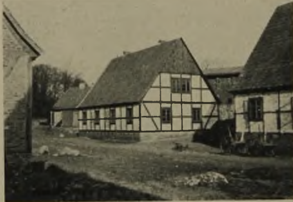
Doppelwohnhaus M 12 und L 11
