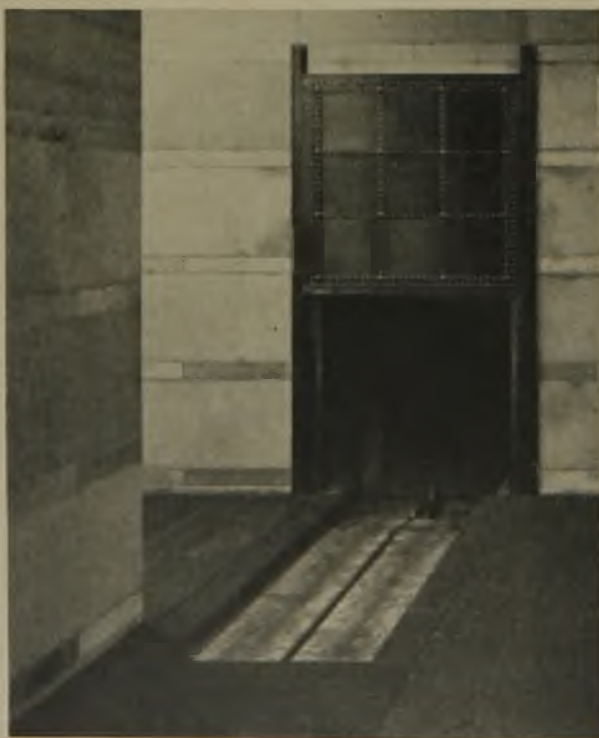
3 Vorraum der Öfen. Sargeinführung mit Bronzeschieber
