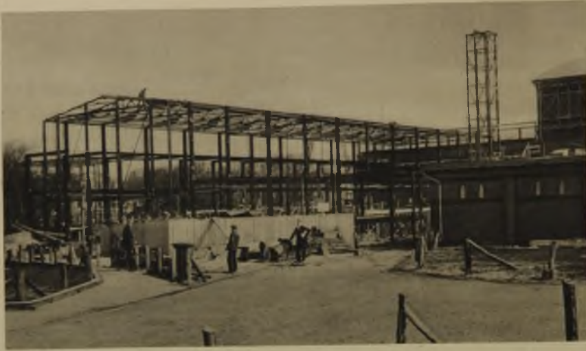
Fertige Montage des Stahlskeletts
