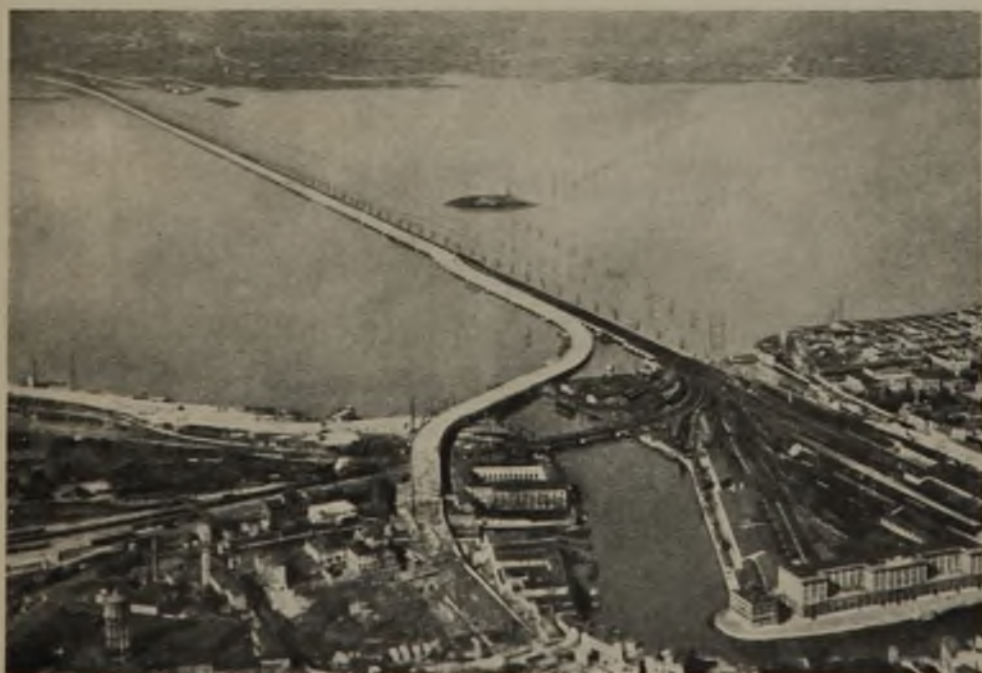
1 Die neue Kraftwagenbrücke ist mit 3977 m Länge von San Giuliano auf der Küstenseite bis zum Parkplatz die längste Brücke der Welt. Sie ist 20 m breit, davon der Fahrdamm für Kraftwagen und Omnibusse 16,5 m und hat 225 Öffnungen.
