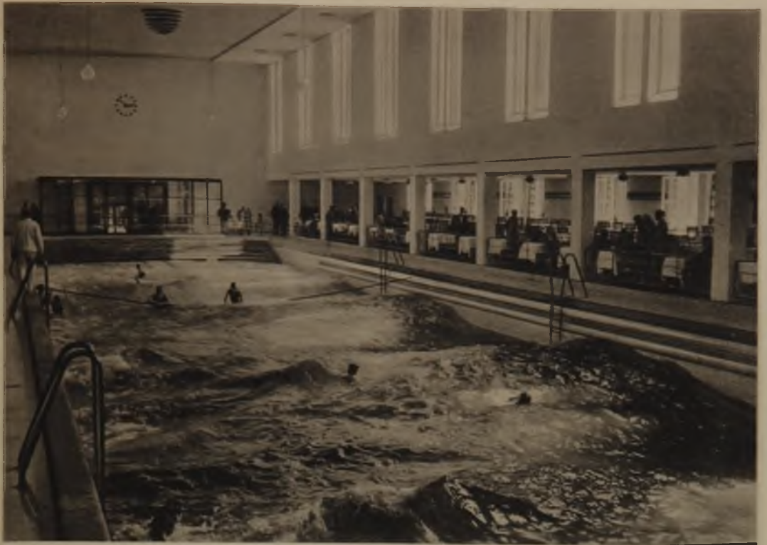
Blick zur Vorhalle Höhe des Raumes 9,17 m
