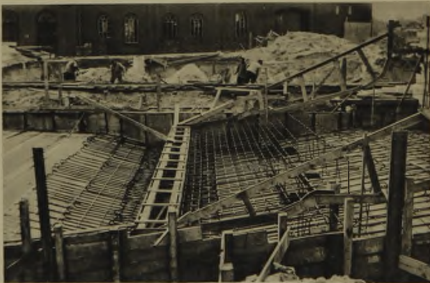
Armierung der Beckensohle, tiefer Teil mit Abflußrinne
