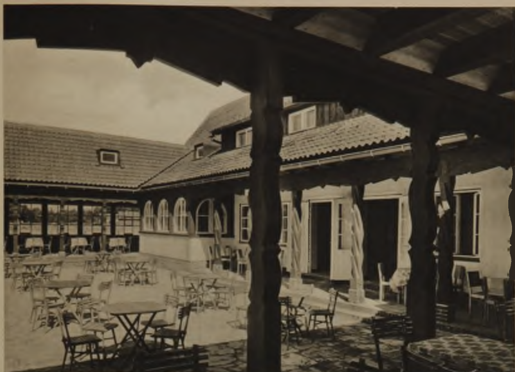
Blick von der rechten Vorhalle auf den Freiplatz vor dem Hause
