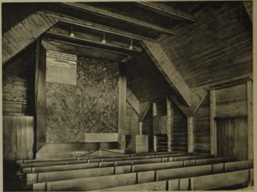
Inneres der Schauhalle mit dem Tannen- bergrelief von Lehrer Mantau-Danzig Des freien Überblickes wegen ist die Konstruktion teilweise nach außen verlegt. 100 Plätze. Verschalung geölt und ohne Farbzusatz lackiert
