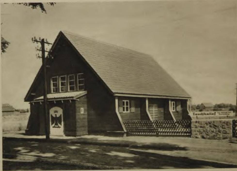
Schauhalle beim Tannen- Krug Abstrebungpfeiler mit Kupfer gedeckt. Adler auf der Tür aus einzelnen Kupfertafeln aufgenietet
