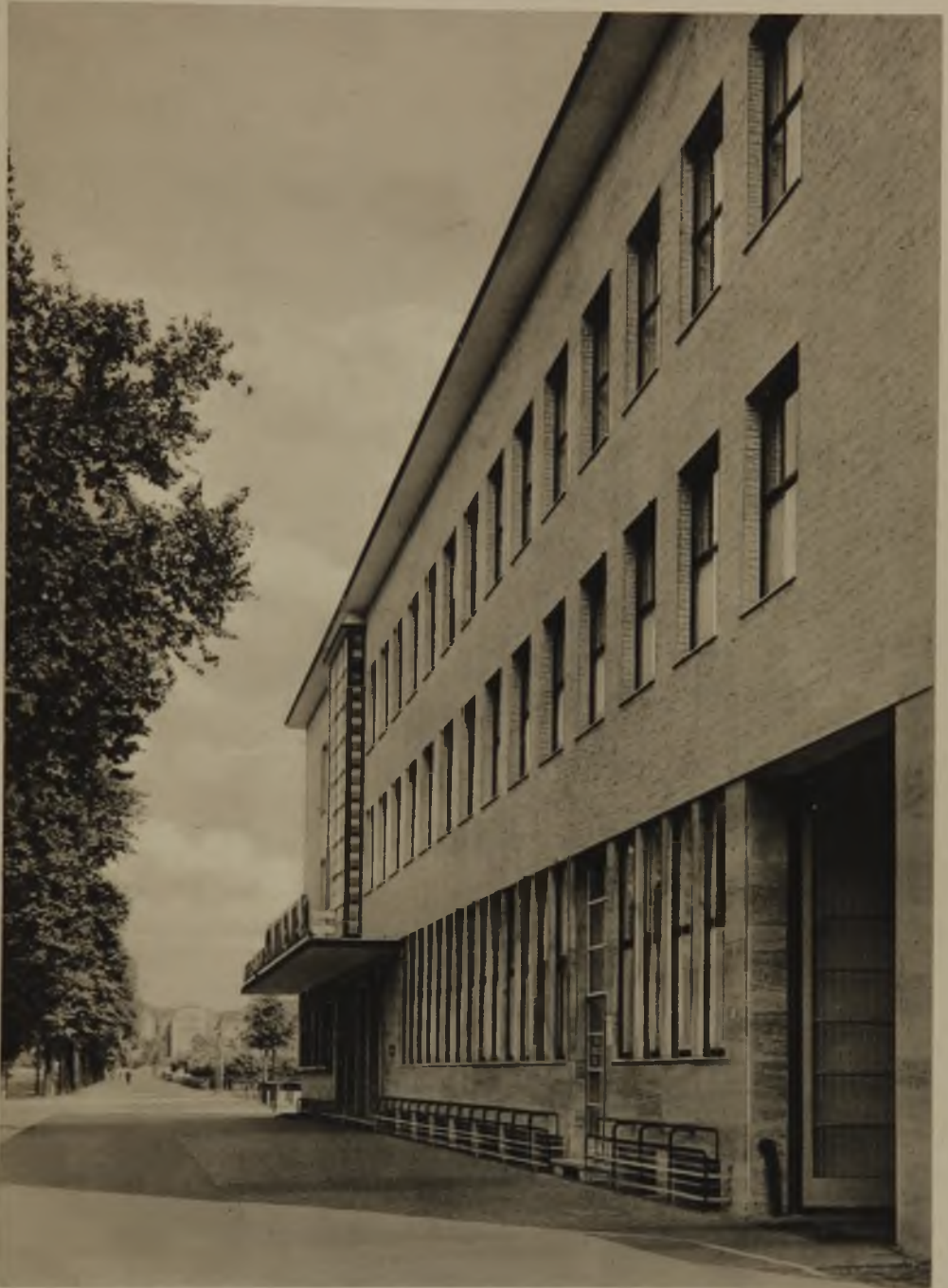
Ansicht Aachener Straße (1. Bauabschnitt)
