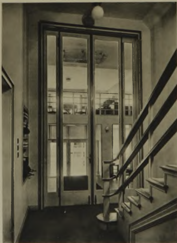
Blick vom Treppenhaus zum Zwischengeschöß
