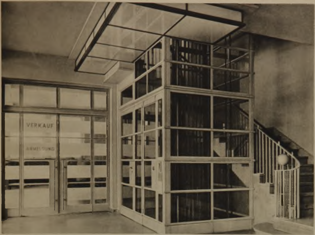
Ausschnitt aus der Eingangshalle. Aufzuggerüst Eisen, Verglasung in Drahtspiegelglas, Treppen- und Bodenbelag aus deutschem Jurakalk, Geländer Eisenfladstöße mit gebeiztem Buchenhandlauf
