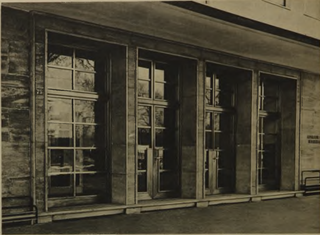
Ausschnitt des Haupteingangs, Türen nach außen mit Messing brüniert verkleidet, innen Eiche natur, Umrahmung in Muschelkalk-Kernstein geschliffen
