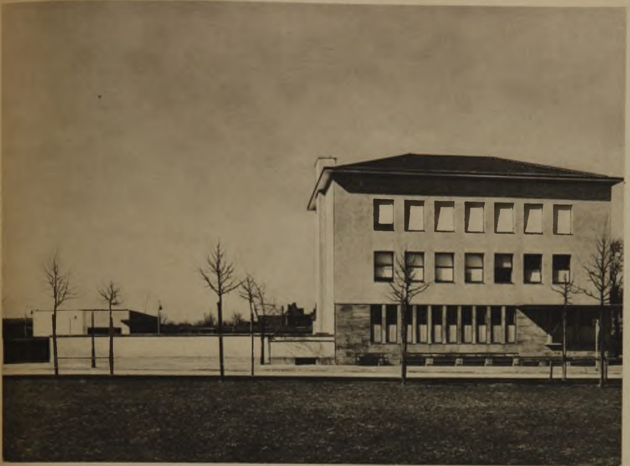
Frontseite zur Kanalstraße (1. Bauabschnitt). Erweiterungsmöglichkeit der Front vorgesehen, desgleichen Aufstockung um mehrere Geschosse, daher leichtes Holzdach mit Ludowici-Ziegeln ausgeführt
