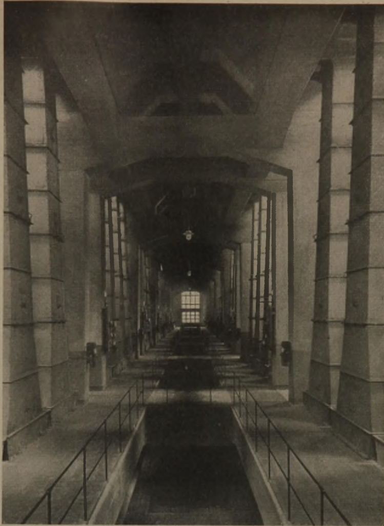
Abb. 14 (unten). Kesselhaus mit Kohlenzuführung.
