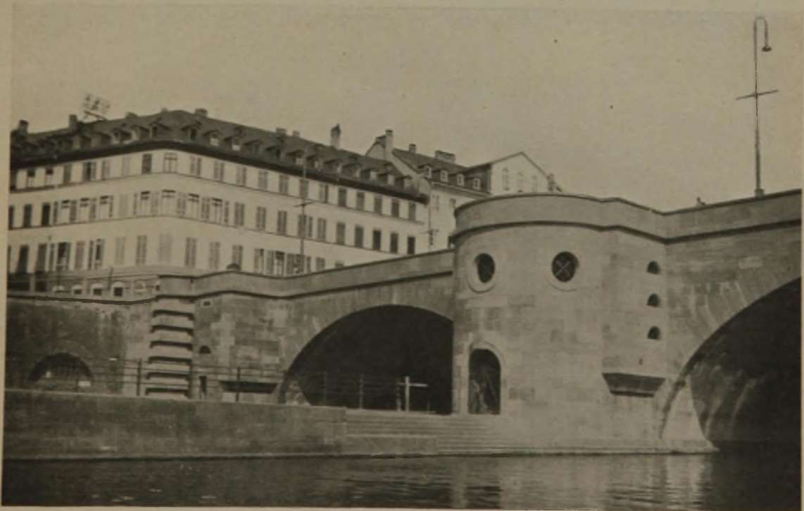
Abb. 12 (oben). Modellbild von oberhalb gesehen. Abb. 13 (Mitte). Blick gegen die neue Brücke nach Sachsenhausen zu. Abb. 14. Uferschluß, Frankfurter Seite.
