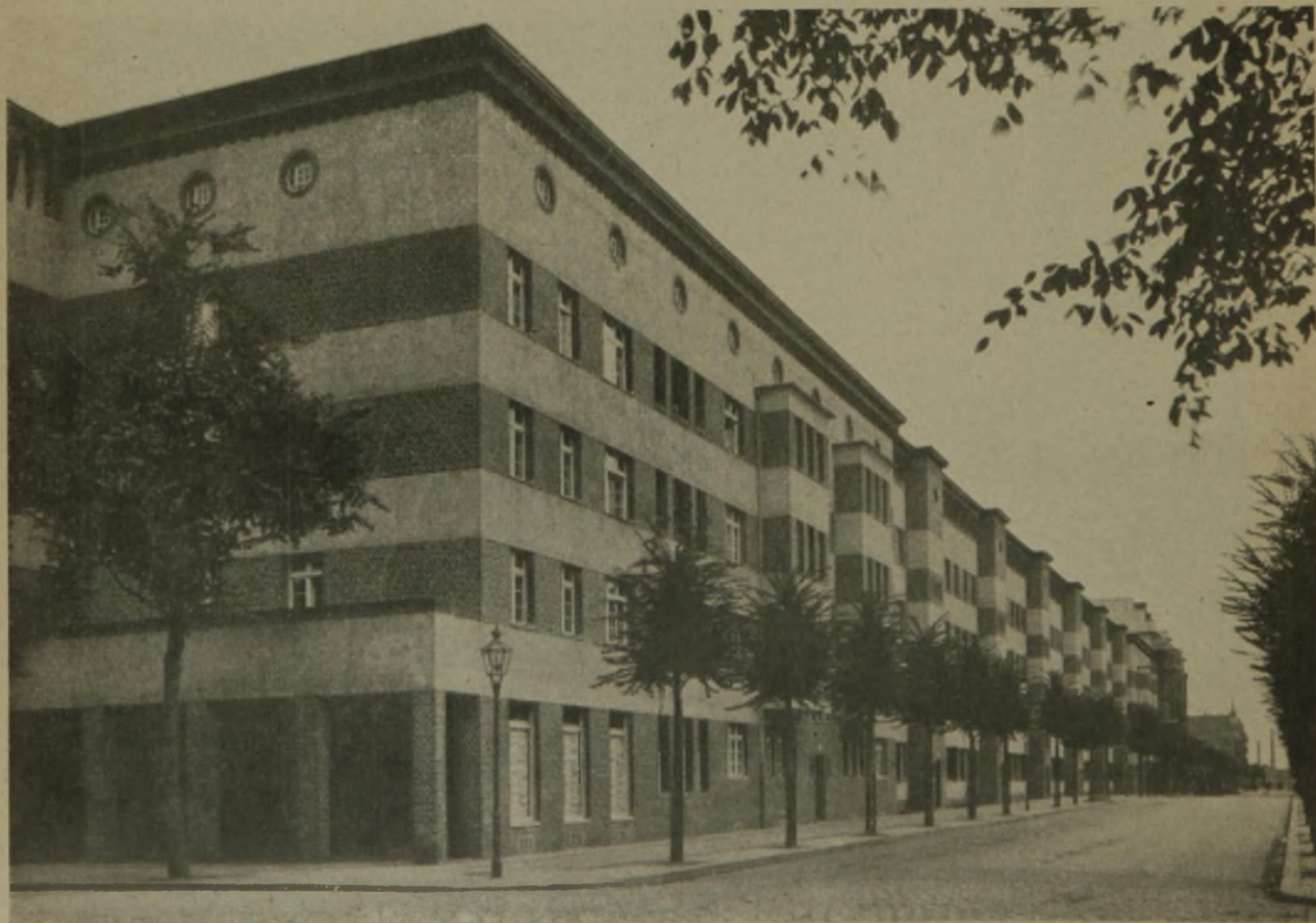
Abb. 1. Ansicht Ecke Inn- und Weserstraße mit Blick in letztere.
