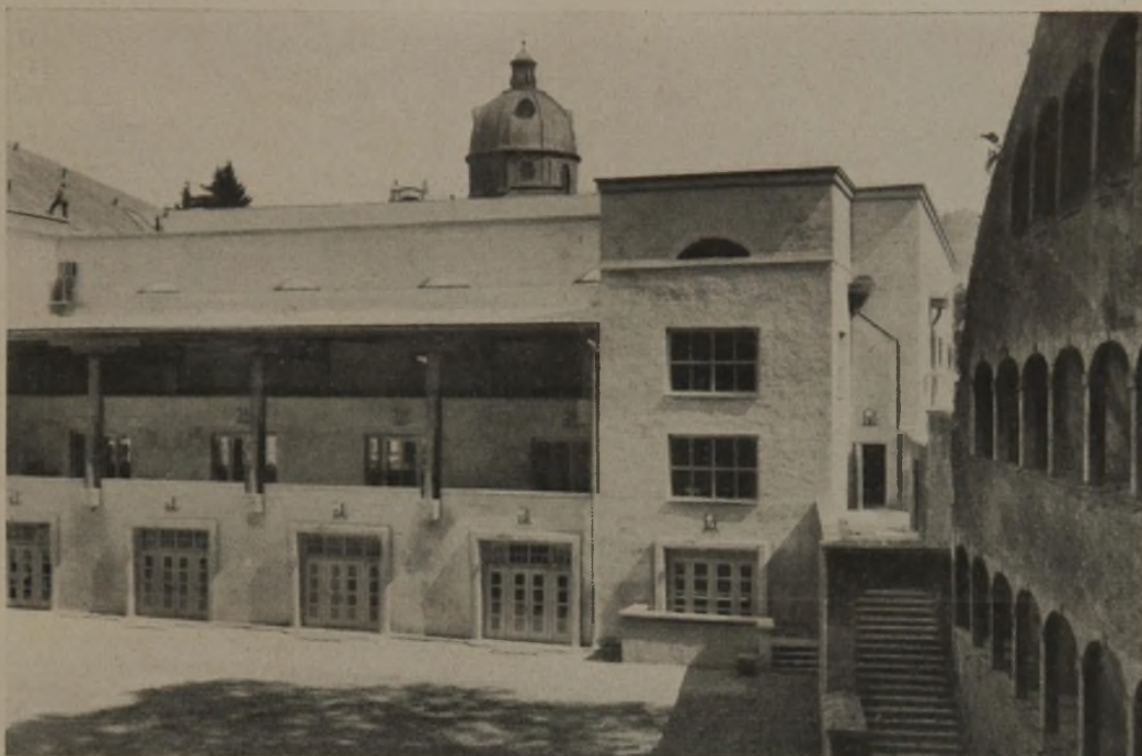
Abb. 4. Festspielhaus Salzburg, Hofansicht. Blick auf umgebaute große Winterreitschule.
