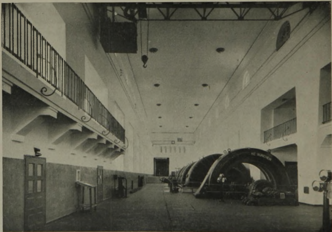
Abb. 7. Blick in den Hauptmaschinenraum mit den Generatoren. (Phot. Aufnahmen von Jaeger & Goergen, München.)
