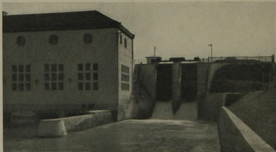
Abb. 2 (oben.) Blick auf das Kraftwerk durch die Brücke über den Unterwasser- kanal.
