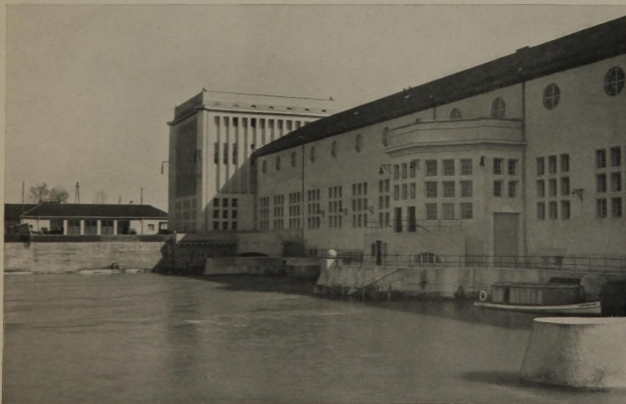
Abb. 1. Blick gegen das Kraftwerk von unterhalb. (Phot. Jaeger & Goergen, München.)
