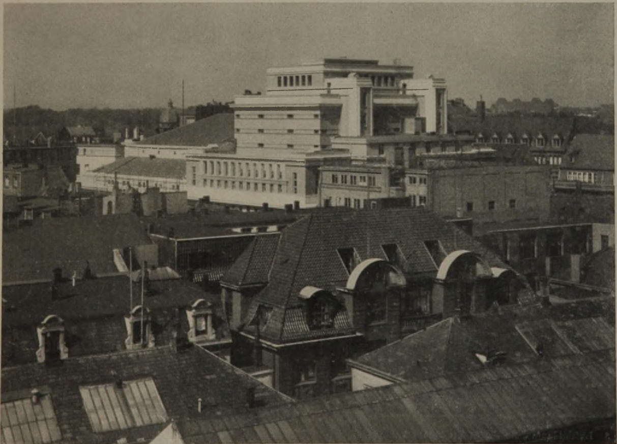
Abb. 1. Silhouette des Stadttheaters nach dem Umbau. Blick auf das Bühnenhaus. (Alle Aufnahmen von Phot. L. Meyer, Hamburg 23.)
