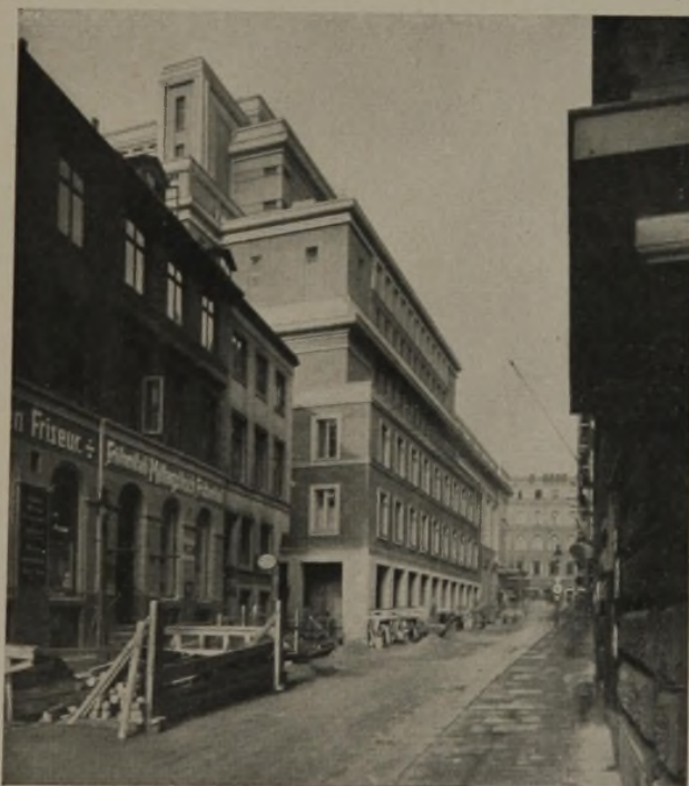
Abb. 11 (oben). Blick auf das neue Bühnenhaus. Abb. 12 (unten). Bühnenhaus. Große Theaterstraße. Architekten: H. Distel und A. Grubitz, Hamburg.
