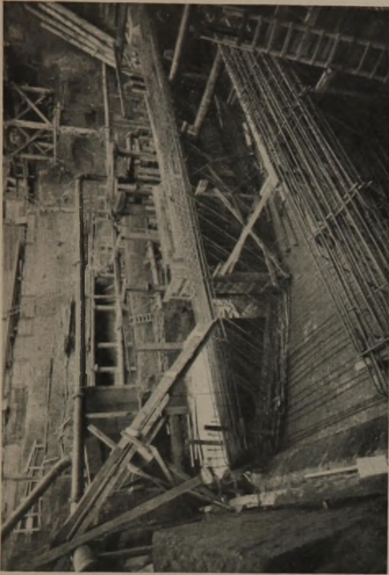
Abb. 20. Bewehrung der beiden Soblenträger.
