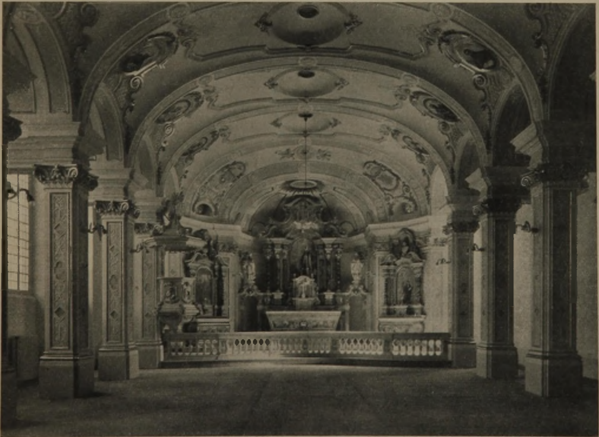
Abb. 9. Blick in die Kapelle gegen Hauptaltar und Seitenaltäre. Provinzialhaus der „Grauen Schwestern“ i. Halle a. S. Architekt: Paul Fischer, Halle a. S.
