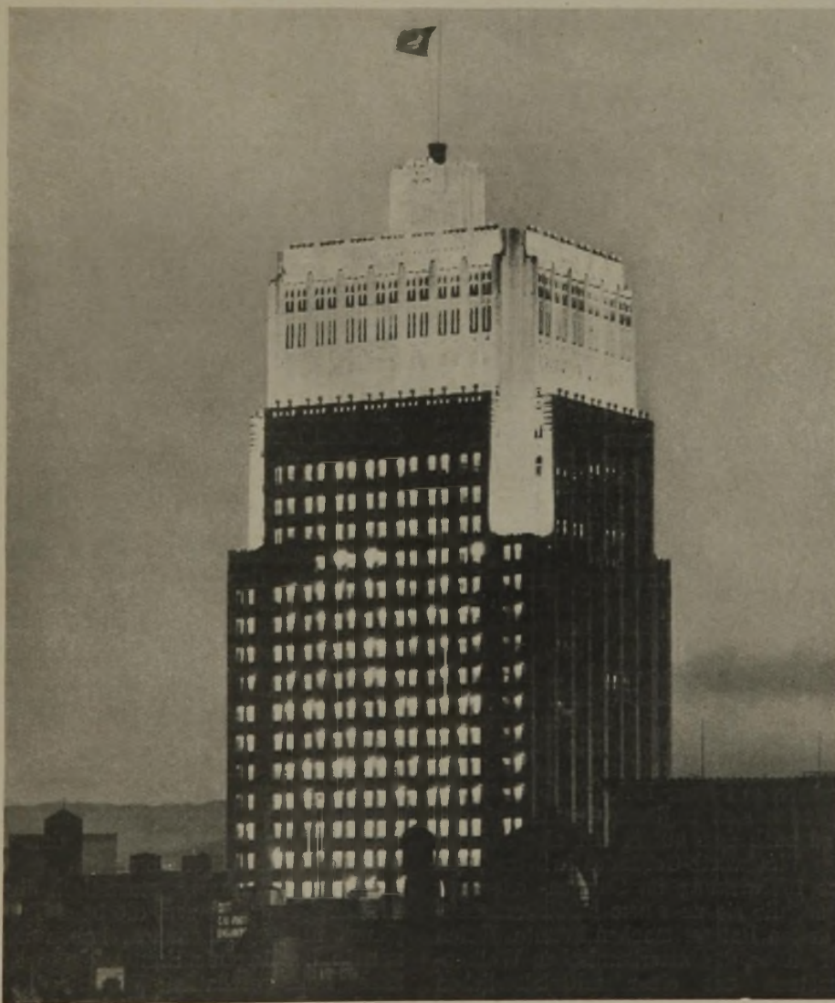
Abb. 1. Das Bürogebäude der Pacific Telephone and Telegraph Company, San Francisco.
