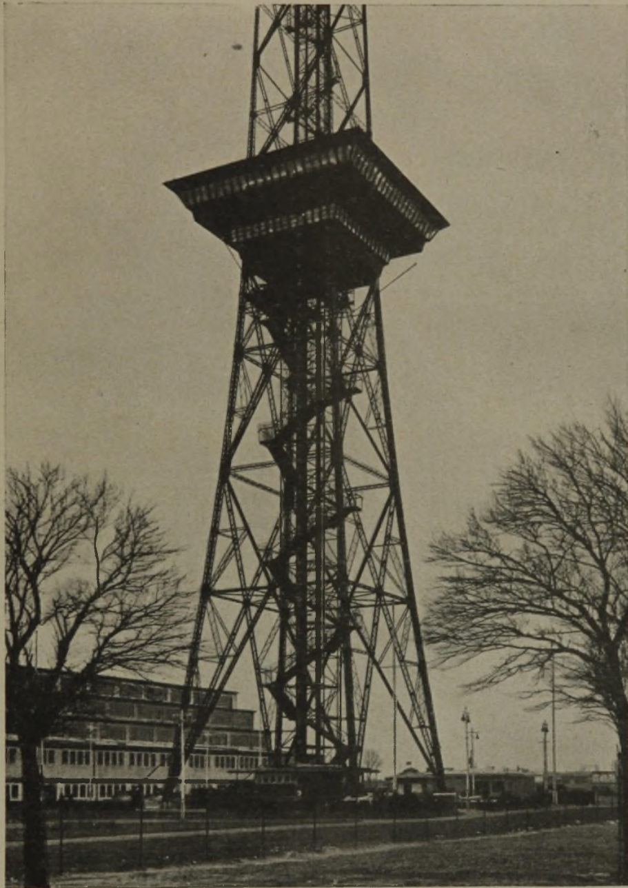
Abb. 5. Unteres Turmgeschoß mit Eingangshäuschen. Architekt: Prof. Heinrich Straumer. Ing. Hein, Lehmann & Co., Berlin.
