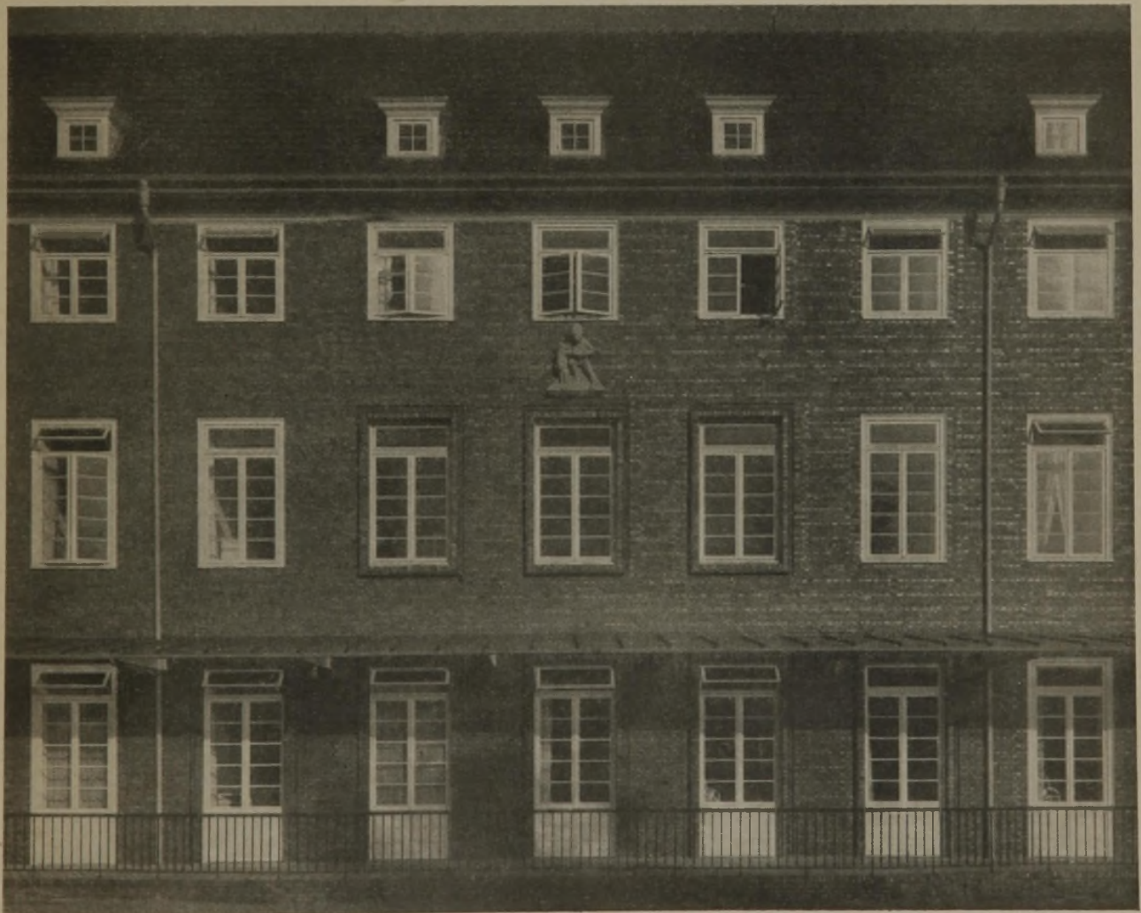
Abb. 1. Chirurgische Klinik. Mittelbau Südseite. Arch. Mag.-Baurat Lembke, Harburg.
