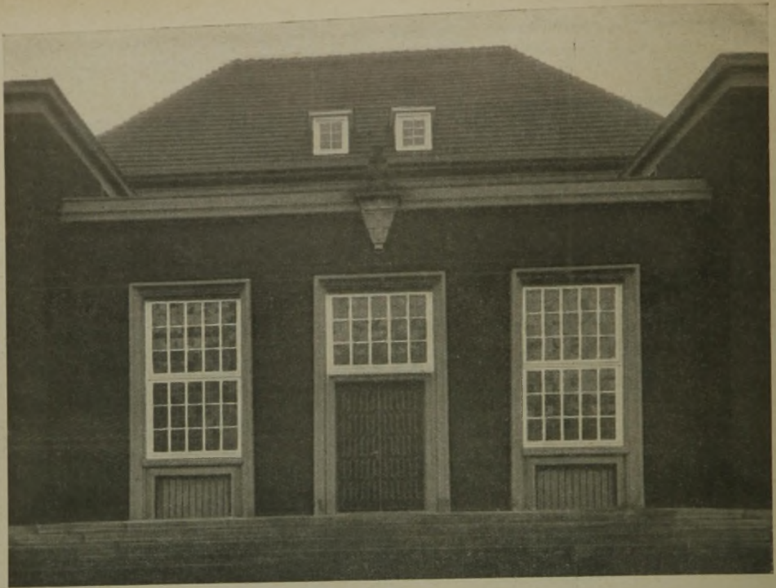
Abb. 8. Prosektur und Kapellenbau. Mittelbau und Kapelleneingang.
