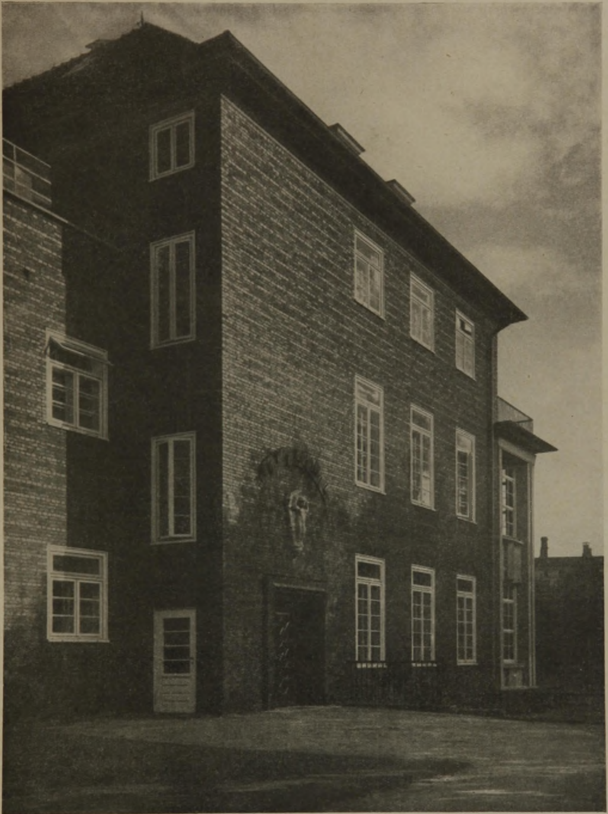
Abb. 10. Chirurgische Klinik. Westeingang. Männerseite. Architekt: Mag.-Baurat C. L e m b k e, Harburg. Städtisches Krankenhaus in Harburg-Elbe.
