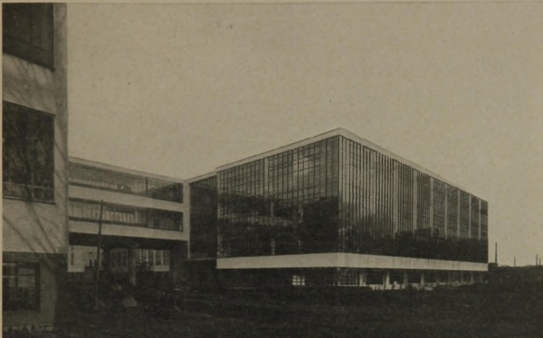
Abb. 13. Das Werkstattgebäude. Westseite.
