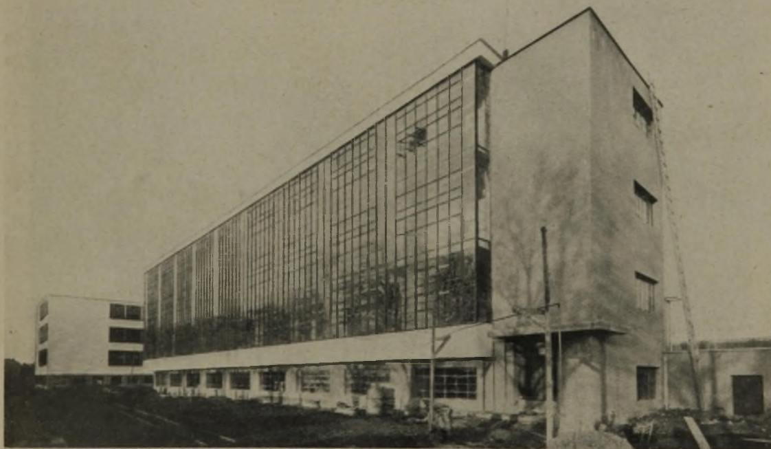
Abb. 14. Das Werkstattgebäude mit Treppenhausanbau.
