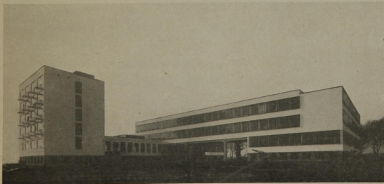
Abb. 1. Blick auf Atelier- und Fachschul-Gebäude.
