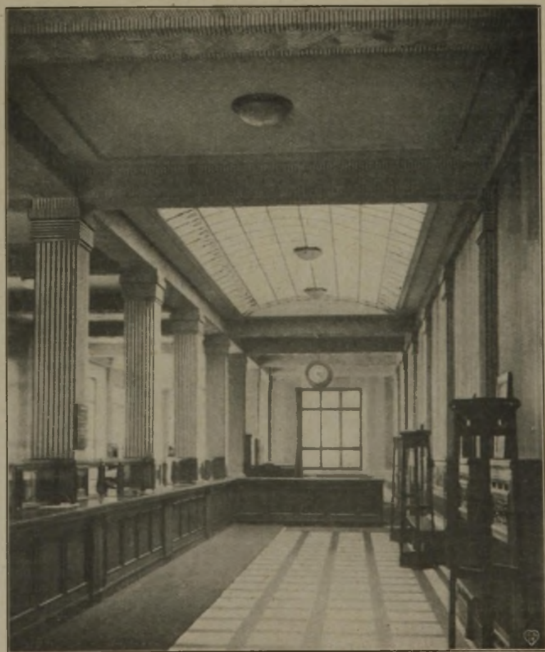
Abb. 7 (links). Kassenraum der Stadtbank Wattencheid. Säulen u. Decken ausgeführt in K-Steinputz.
