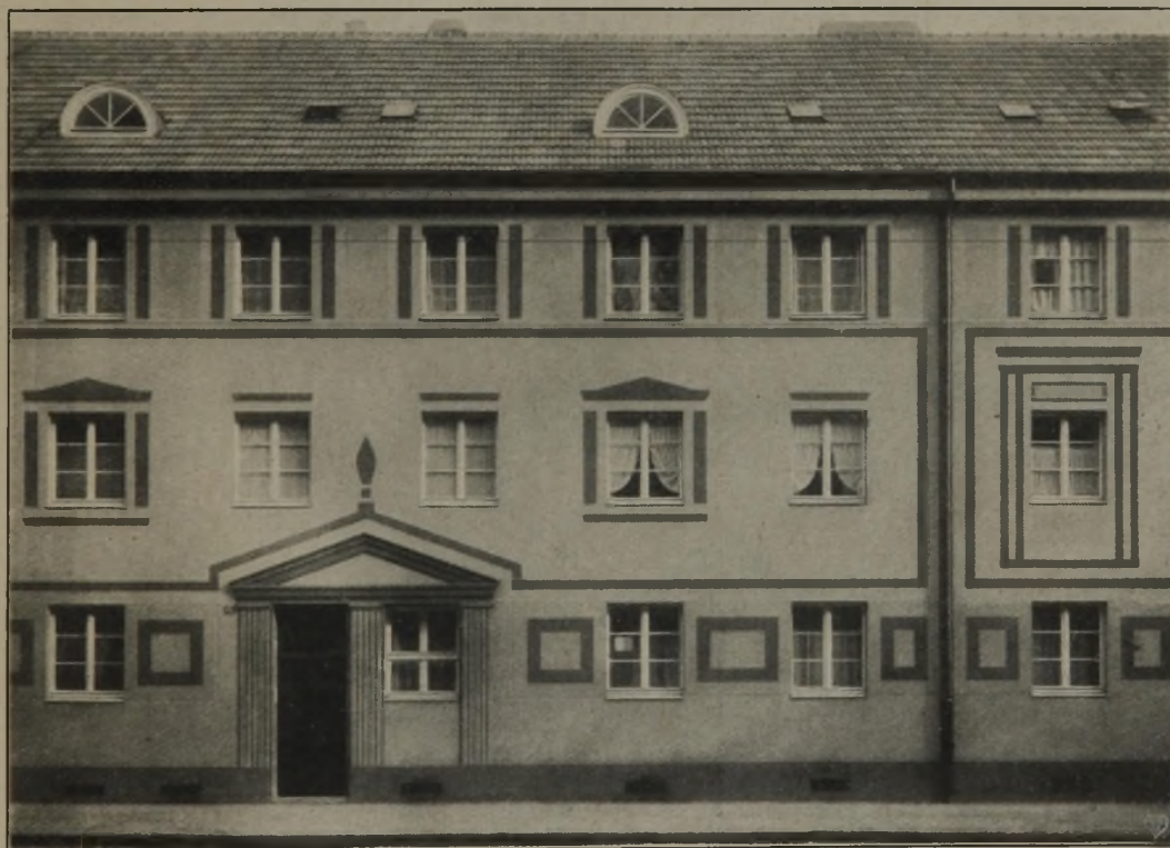
Abb. 3. Siedlung Köln-Mülheim. Verputz in farbigen Trockenmörteln der Terranova- und Steinputzwerke, Düsseldorf.
