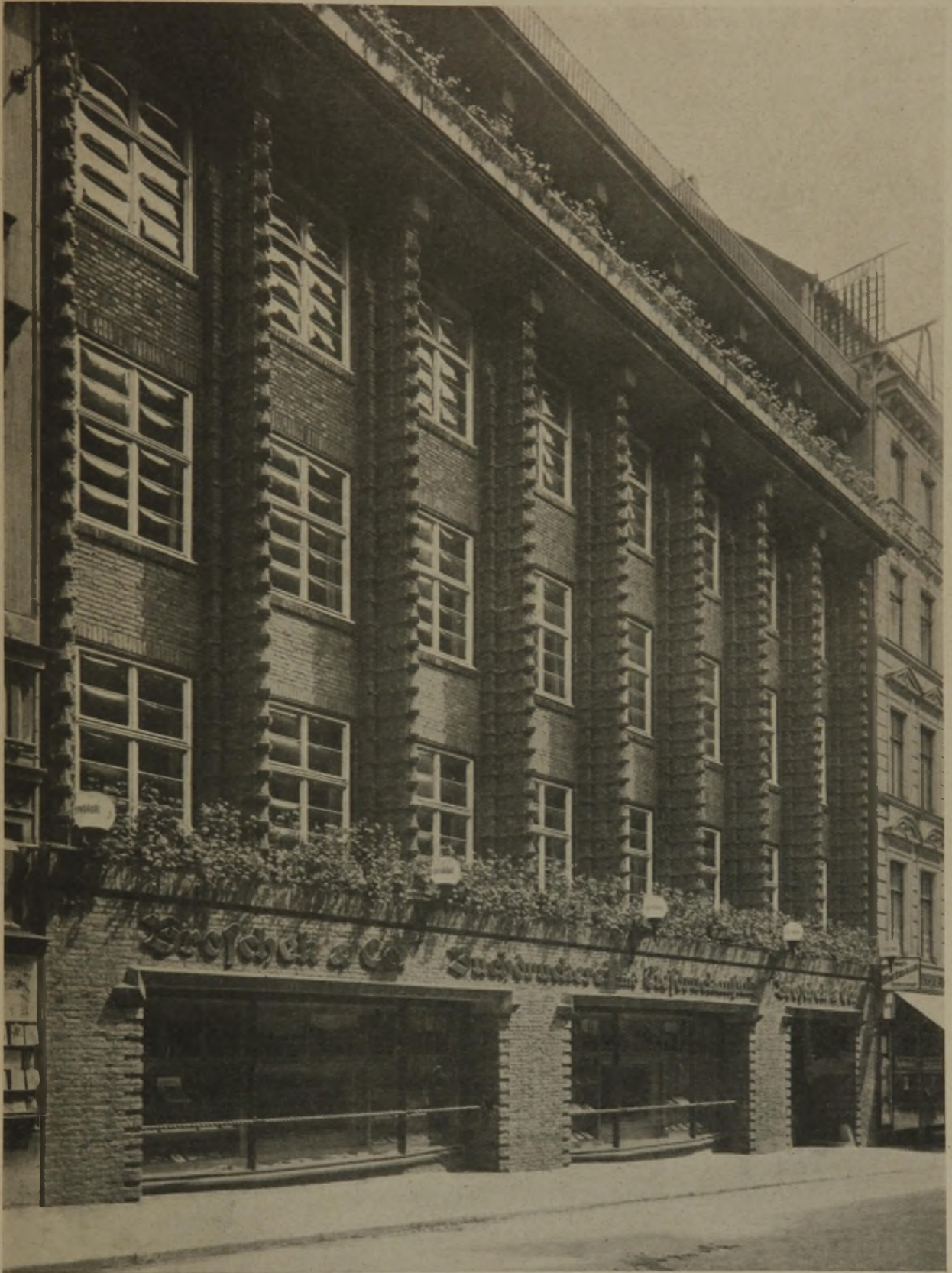
Abb. 7. Fassade des I. Bauabschnitts am Heuberg. Neubau Hamburger Fremdenblatt. (Buchdruckerei Broschek & Co.) Architekt: Fritz Höger, Hamburg.
