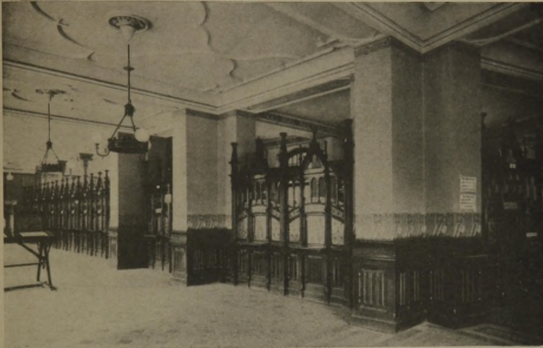
Abb. 1. Schalteranlage vom Postamt 1 Düsseldorf. (Früherer Zustand, erbaut 1902/04.)
