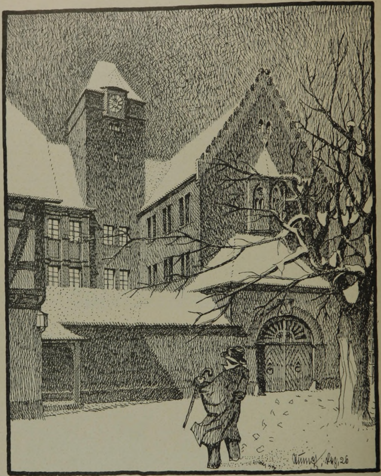
Die Höhere Landesbauschule in Darmstadt.
