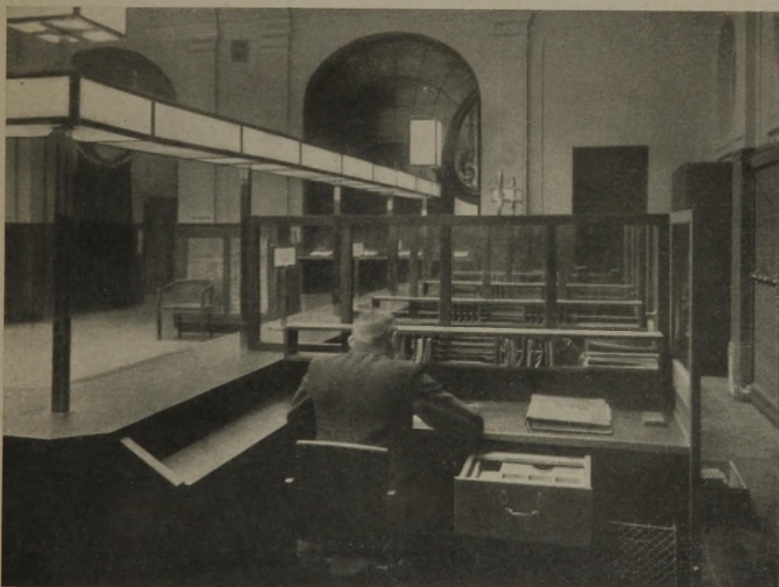
Abb. 6. Schalteranlage des Hauptpostamts in Potsdam
