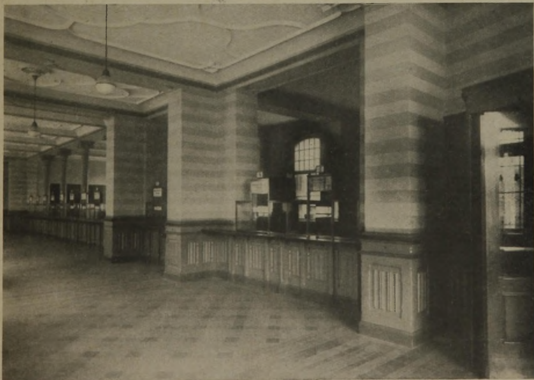
Abb. 2. Schalteranlage vom Postamt 1 Düsseldorf. (Nach dem Umbau.)
