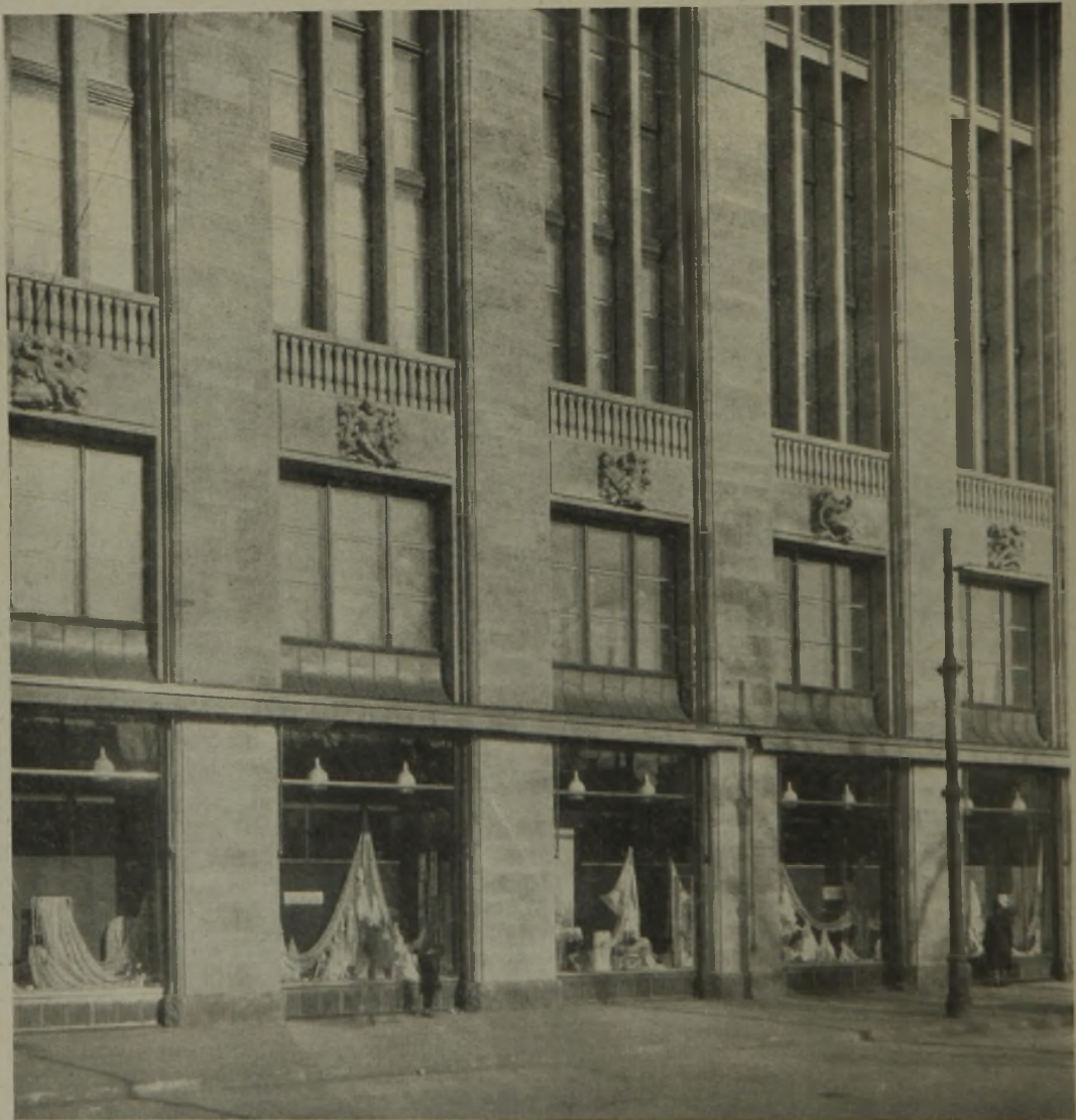
Abb. 7. Fassadengestaltung am Leipziger Platz. (Skulpturen Prof. Wilh. Gerstel.) Material: Fränkischer Muschelkalkstein. (Brüche Kleinrinderfeld bei Kirchheim der Firma Zeidler & Wimmel, Berlin.) Erweiterungsbau des Warenhauses Wertheim in Berlin.
