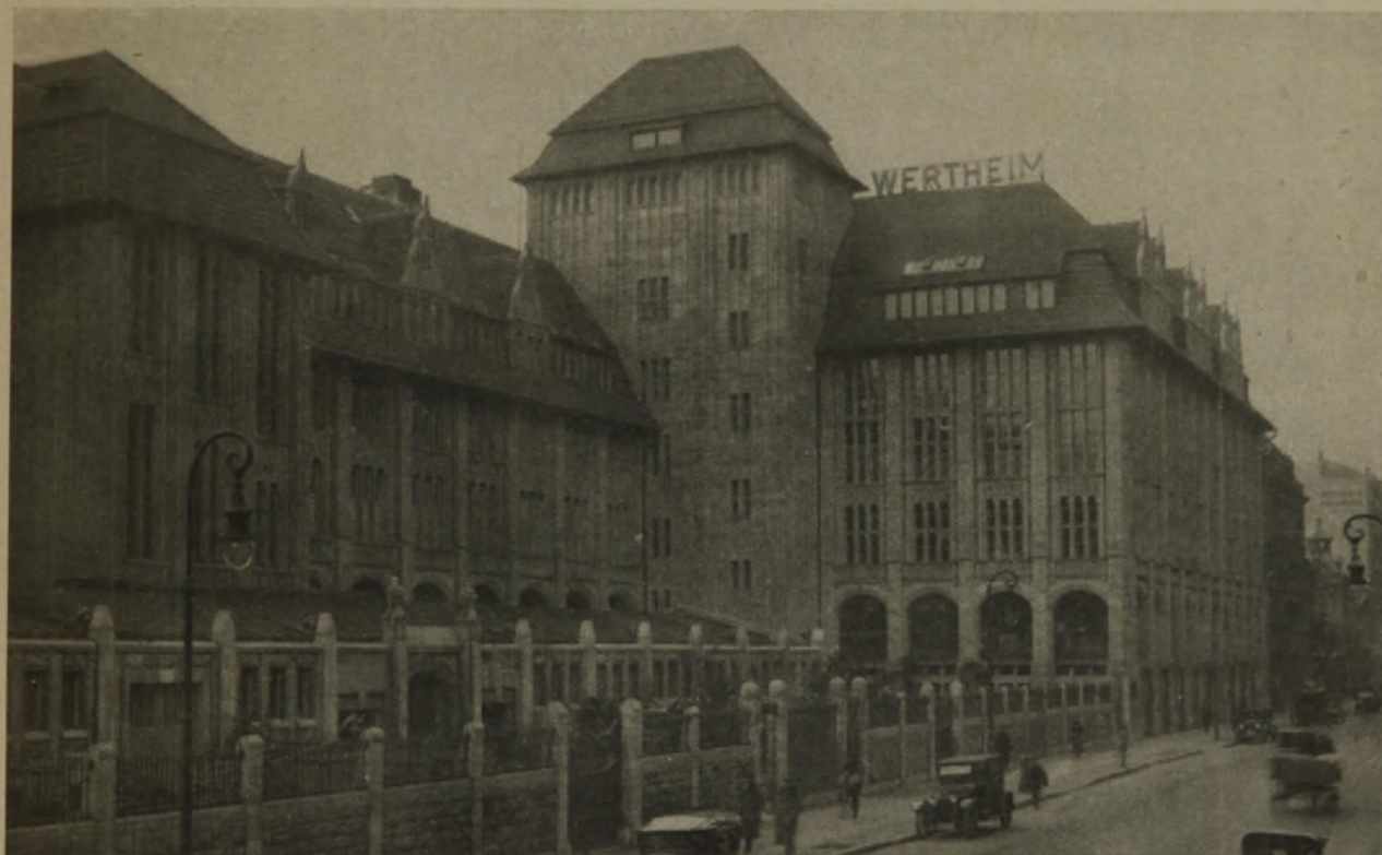
Abb. 5. Ansicht des Erweiterungsbaus an der Voßstraße.
