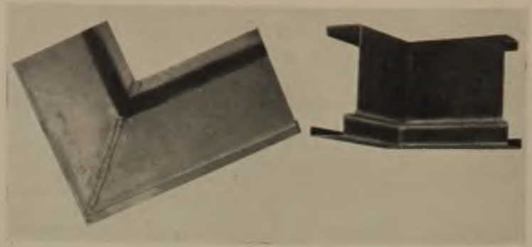
6 a Starre Verbindung zwischen Längs- und Querträger (I-Profil; siehe die Versteifungseckbleche)
