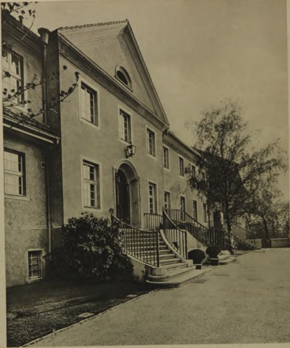
Neuerbauter Mitteltrakt mit Freitreppe. Treppenanfänge in reichgegliedertem Guß- eisen. Stäbe und Handleiste in Schmiedeeisen
