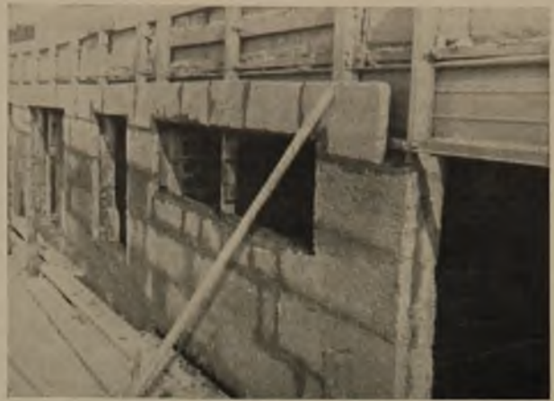
9 Verkleidung der Außenwand mit Bimsbetonplatten
