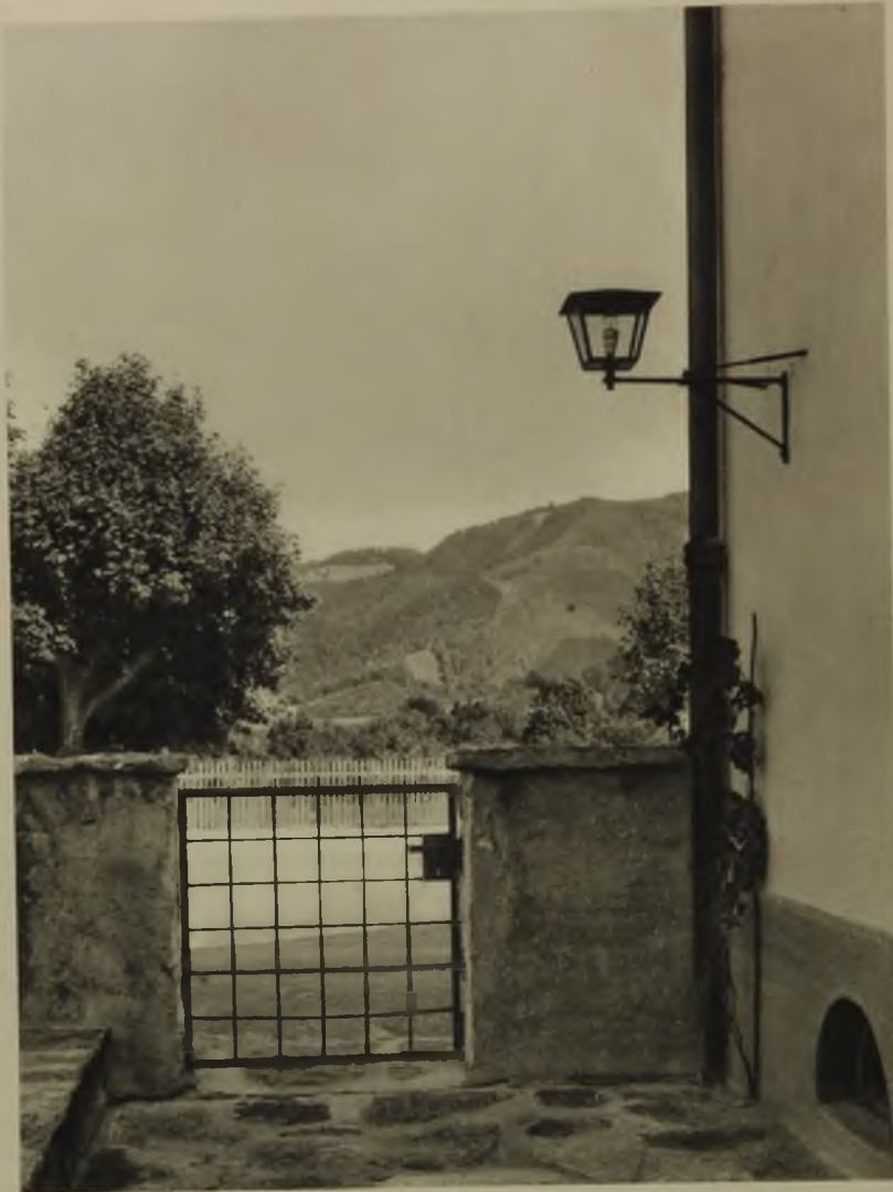
Gittertür zwischen Betonpfeilern (Postwohngebäude, Bad Wiessee). Vom Sockel bis hinauf zum Gesims und zum Kaminkopf gibt es keine bauliche Einzelheit, deren liebevolle, handwerkliche Durchbildung für die Gesamtwirkung eines Bauwerks nicht ebenso wichtig wäre, wie der Entwurf des Hauses selbst
