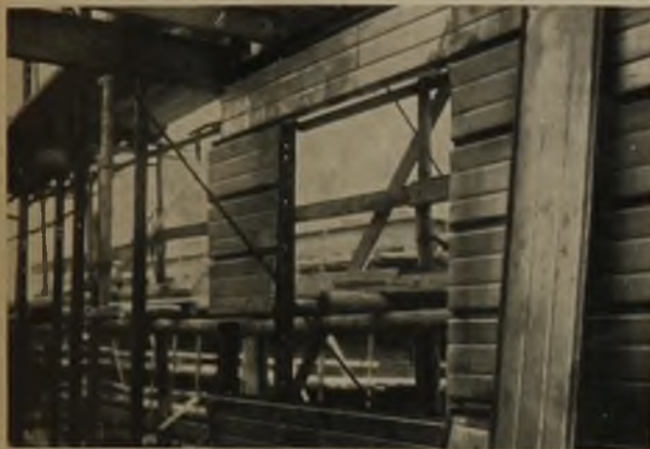
8 Verkleidung der Außenwand mit Wandblechen
