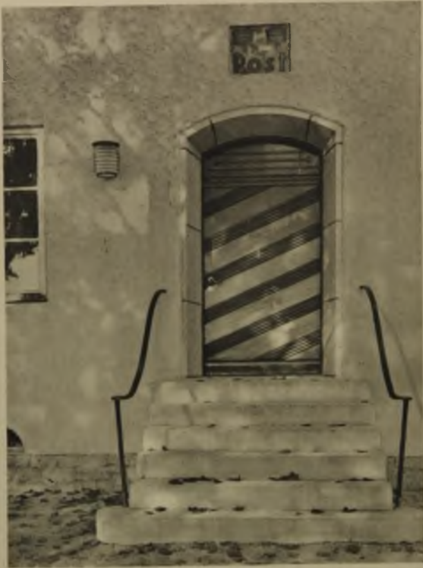
Postamteingang (Schwarzenfeld Opf.). Tür mit schräglaufender Aufdoppelung und Oberlicht. Die Hauseingangstür ist gewissermaßen die Visitenkarte eines Hauses; man soll einer Tür sofort ansehen können, ob es sich um den Haupteingang, den Zugang zu Amtsräumen, oder zu Wohnungen, eine Einfahrt oder ein Garagentor handelt. Bei keinem anderen Teil eines Gebäudes sind Form und Durchbildung von so ausschlaggebender Bedeutung
