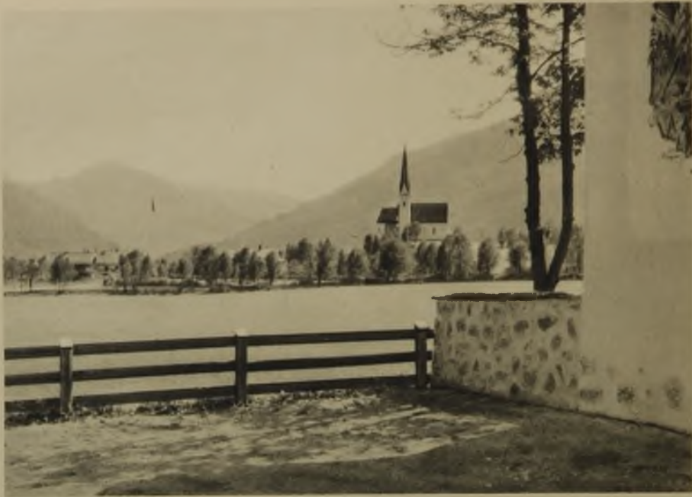
Umfriedungsplanke und Bruchsteinmauer (Postwohn- gebäude Bad Wiessee)
