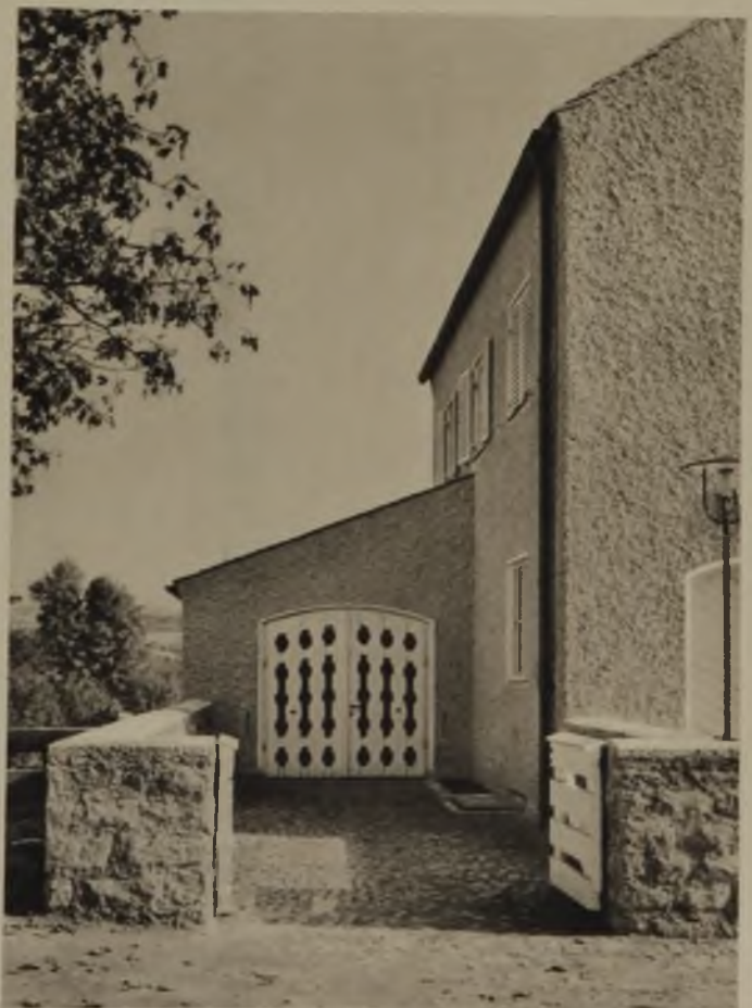
Einfahrt (Postkarrenschuppen Postamt Hauzenberg, Bayr. Wald). Durchbrochene Tür aus ausgesägten Brettern, gehobelt und gestrichen
