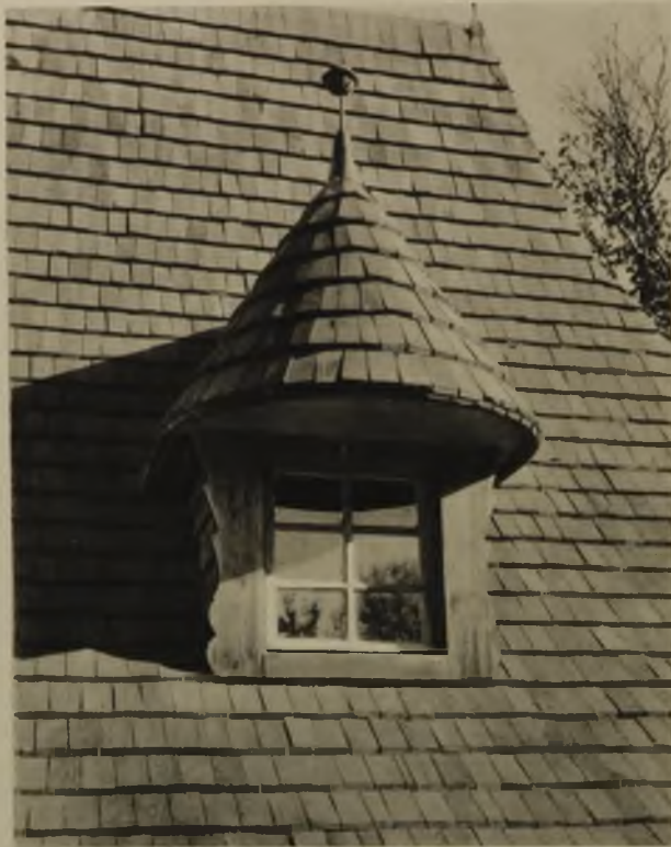
Dachgaube (Postkarrenschuppen Mindelheim, Schw.) Schindeln und Dachfenster aus Lärchenholz, Gaubenspitze aus Kupfer
