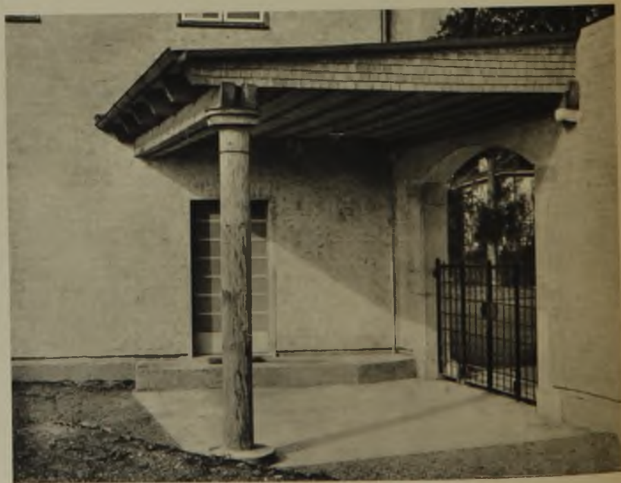
Vordach (Postamt Gundelfingen, Schw.). Feinere Behandlung der Lärchenholzteile mit Rücksicht auf die Struktur der verbandeten Wandflächen
