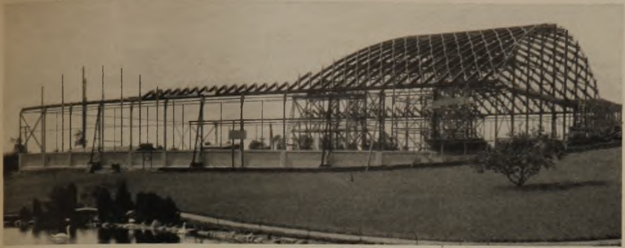
1 Montage vom fahrbaren Arbeitsgerüst im freien Vorbau
