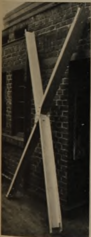
5 Knotenpunkt des Stahl- lamellennetzes Bauart Hünnebeck
