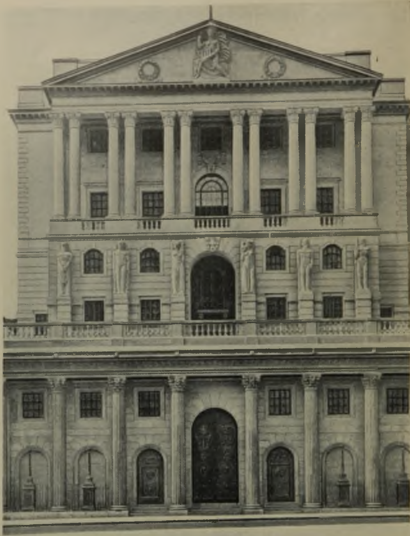
Neue Hauptfassade an der Threadneedle Str. Teils alt, teils in den alten Formen
